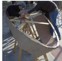
Fig. 4-5: Agrafage d'une laize de carton
