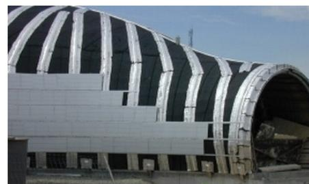
Fig. 5-5: Etanchéité et fixation du bardage final
