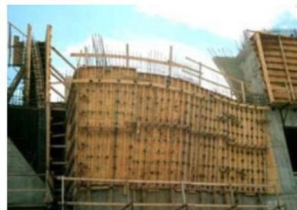
Fig. 5-11: Coffrage d'un voile béton par génératrices rectilignes
