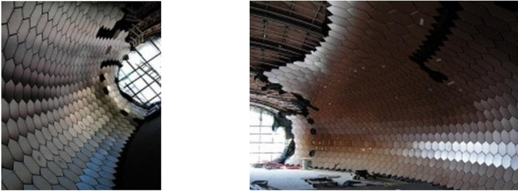
Fig. 5-6: Calepinage d'hexagones (face intérieure)
