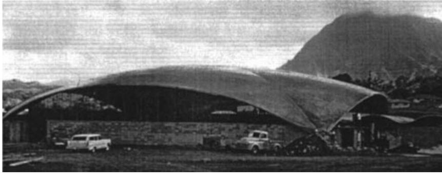
Fig. 4-11: Coque 37m de portée – 64-127mm d'épaisseur sans nervure ni raidisseur – R. Bradshaw
