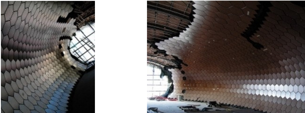
Fig. 5-6: Calepinage d'hexagones (face intérieure)
