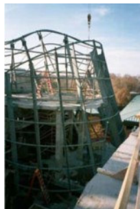
Fig. 5-10: Mise en oeuvre
