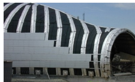
Fig. 5-5: Etanchéité et fixation du bardage final
