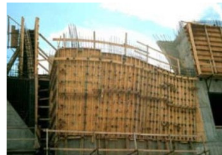
Fig. 5-11: Coffrage d'un voile béton par génératrices rectilignes
