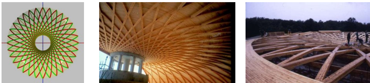
Fig. 3-16: Toit torique d'une piscine – M. Flach – St Quentin en Yvelines – 2004
