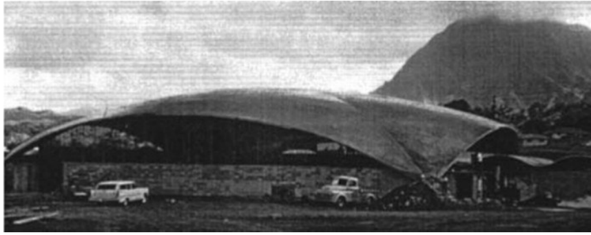
Fig. 4-11: Coque 37m de portée – 64-127mm d'épaisseur sans nervure ni raidisseur – R. Bradshaw
