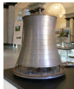
Fig. 4-6: Tour de refroidissement – réseau de câbles – Schlaich Bergermann & Partner – 1974
