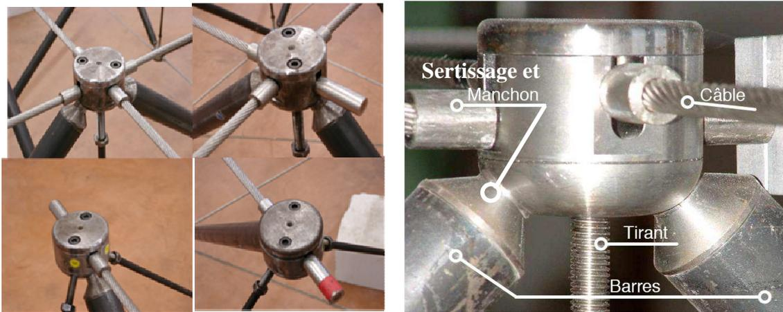
Figure 10. Nœuds de la minigrille, assemblage des éléments.
