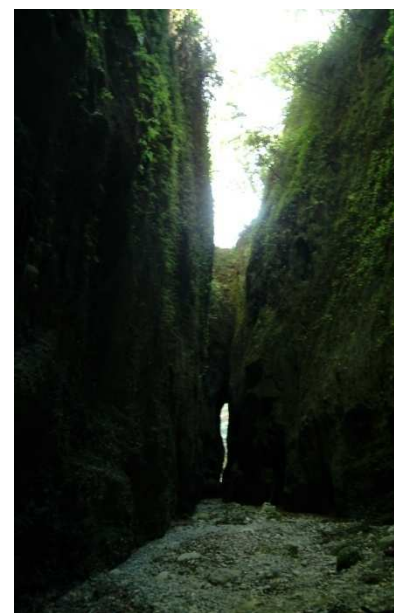
c-Le pont depuis l'amont, Cliché A. Tibaut, 04.07.07
