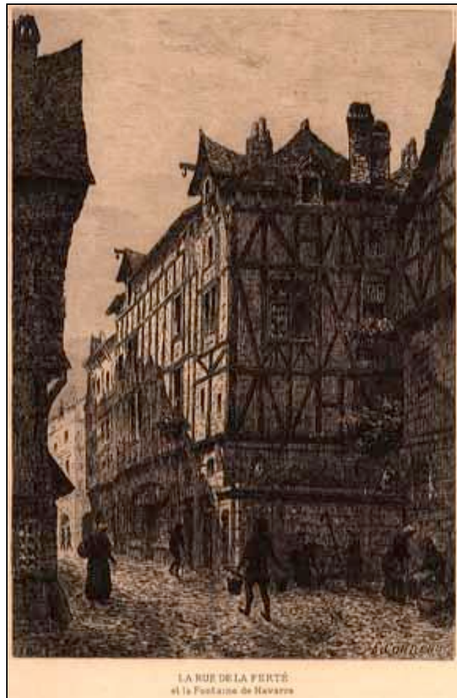
Illustration 40 : La Rochelle. La rue de la Ferté et la Fontaine de Navarre 235 :
