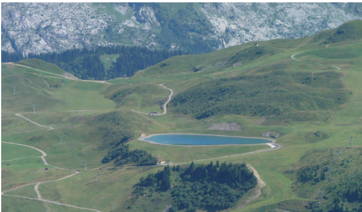
Photo 8.3 : La retenue du Maroly, Le Grand Bornand, Haute-Savoie (cliché : DDEA 74, 2008). Il s'agit de la deuxième plus grande retenue d'altitude française : 300 000 m 3 de capacité utile.
