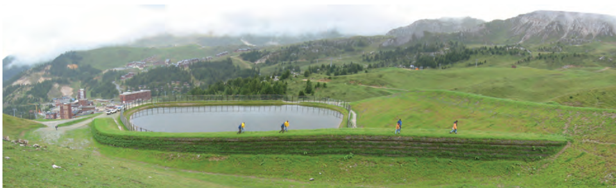
Photo 3.24 : La retenue de la Lovatière sur le domaine skiable de La Plagne, en Savoie (cliché : DDAF 73, le 26 août 2004)
