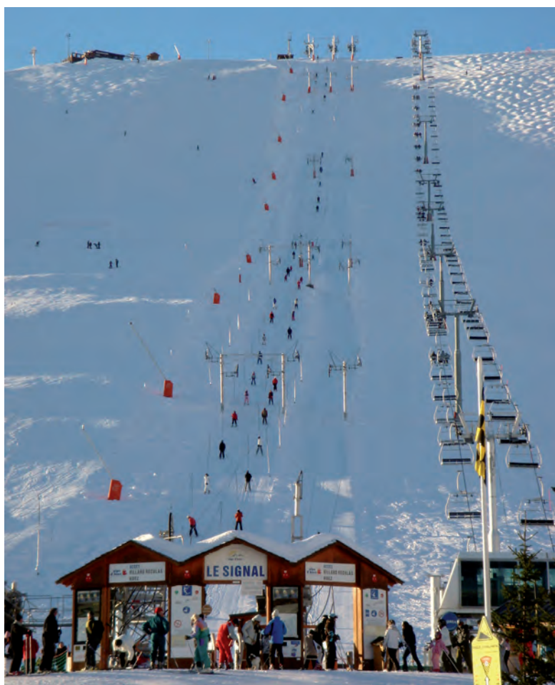
Photo 3.9 : Une ligne d'enneigeurs (10 perches, à gauche) pour deux téléskis et un télésiège débrayable 6 places à l'Alpe d'Huez, Isère, France (cliché : P. Paccard, janvier 2009). La production de neige peut permettre l'exploitation de l'ensemble de ces appareils même lorsque l'enneigement est globalement déficitaire.
