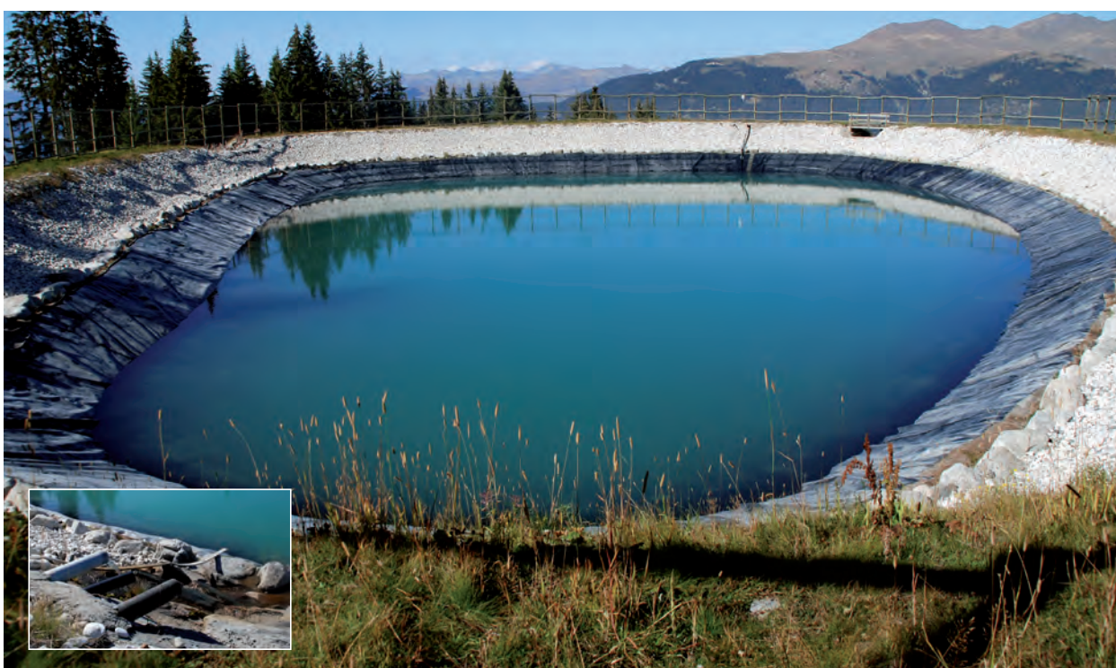
Photo 7.8 : La retenue de Praz-Juget, à l'altitude de 1860 mètres, sur la partie haute du domaine de La Tania (cliché : P. Paccard, le 29/09/2009). En médaillon (en bas à gauche), l'arrivée des canalisations qui alimentent la retenue en eau.
