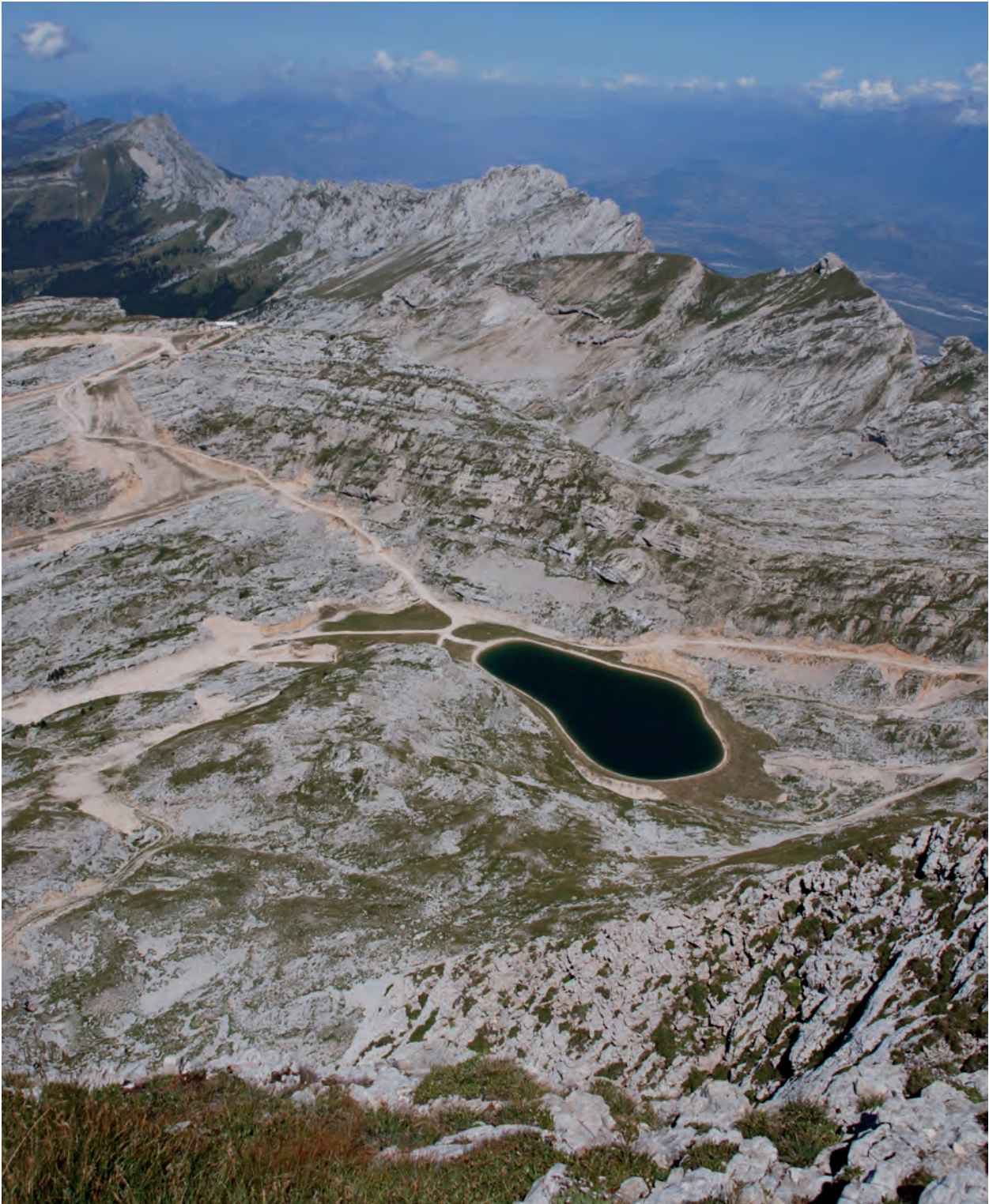
Photo 6.12 : La retenue de la Moucherolle (1915 m) sur la partie haute du domaine skiable de Villard - Corrençon, vue depuis le sommet de la Grande Moucherolle (cliché : C. Gauchon, le 13/08/2009). D'une capacité utile de 100 000 m 3 , elle est aménagée en plein milieu karstique.
