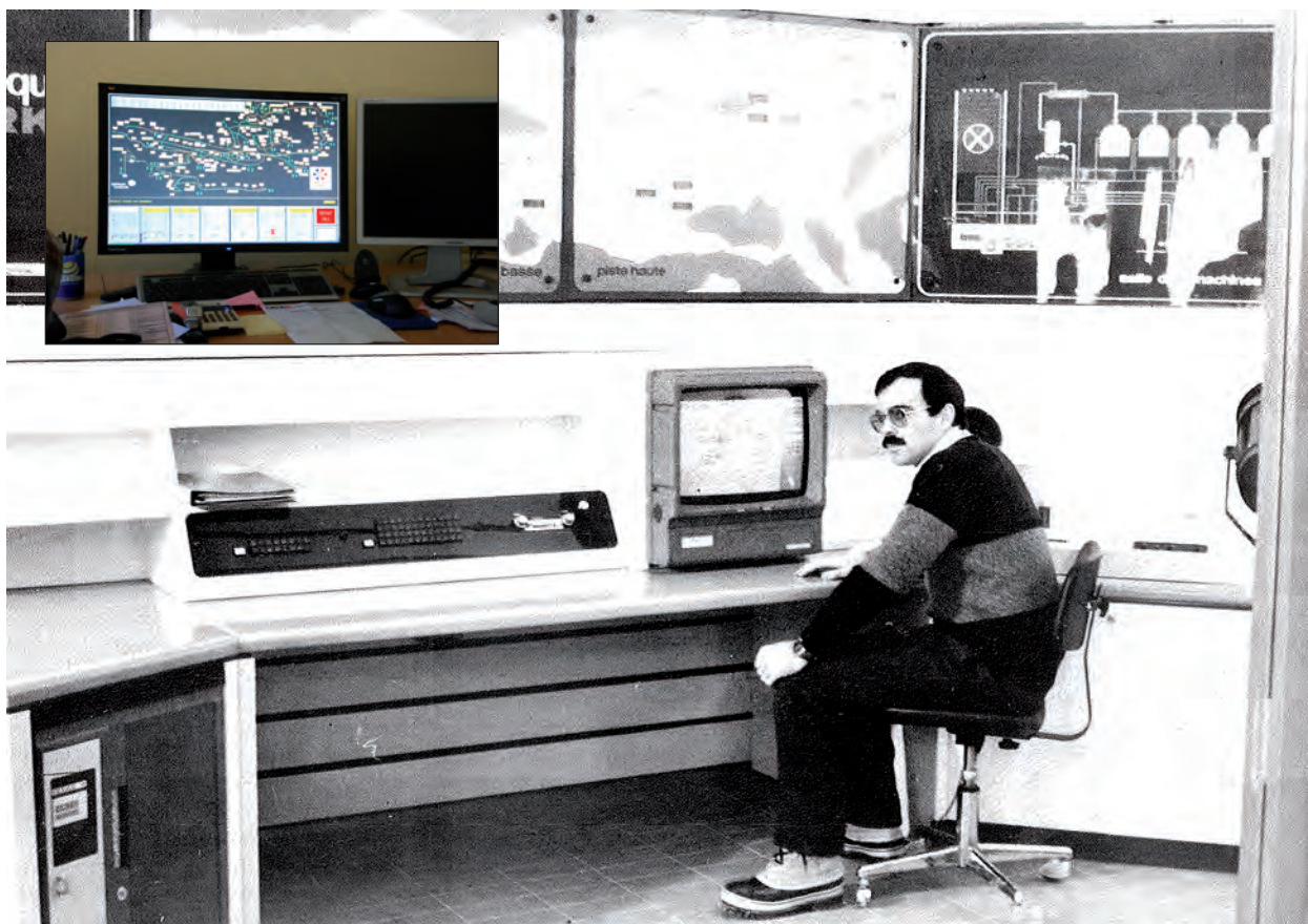
Photo 7.4 : Le pupitre de commande de la première installation d’enneigement de Courchevel (cliché : H. Pelletier, 1983 in Pelletier, 1983, p. 15). En médaillon (en haut à gauche), le contrôle des installations se fait désormais grâce à un ordinateur classique (cliché : P. Paccard, le 29/09/2009).
