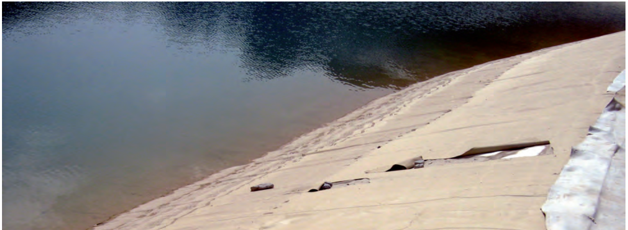
Photo 7.13 : La goémembrane « alimentaire » de la retenue de l'Ariondaz (cliché : C. Petit, S3V, le 24/06/2008). Déchirée par le frottement de pierres entraînées par la reptation de la glace lorsque celle-ci se forme puis casse sur les bords de la retenue, des réparations régulières doivent être faites pour assurer l'imperméabilité de l'ouvrage. Des sortes de « rustines » sont alors collées pour réparer les trous.
