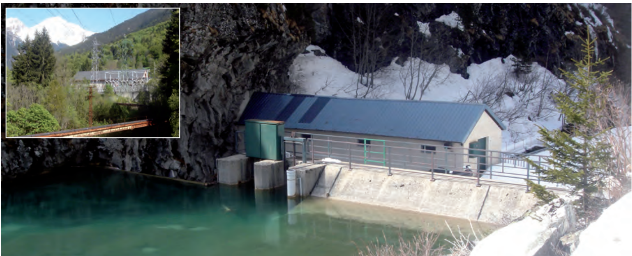
Photo 7.17 : Le barrage communal de La Rosière (cliché : P. Paccard, le 03/04/2009). Juste à l'aval du barrage, le bâtiment prise d'eau d'EDF ; c'est de là que partent les eaux de La Rosière pour être turbinées à la centrale hydroélectrique de Bozel, en médaillon (en haut à gauche ; cliché : P. Paccard, le 07/05/2009).
