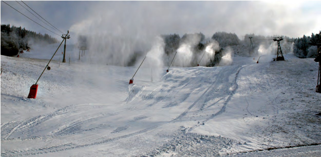
Photo 6.1 : Production de neige en avant saison sur la partie basse du domaine skiable de Villard-de-Lans (cliché : P. Paccard, le 15/12/2009). Le domaine skiable de Villard-Corrençon est équipé de plus de 250 enneigeurs bifluides. 3 « salles des machines » (usines à neige) regroupent les installations de compression d'air et de pompage de l'eau nécessaires à l'alimentation des enneigeurs.
