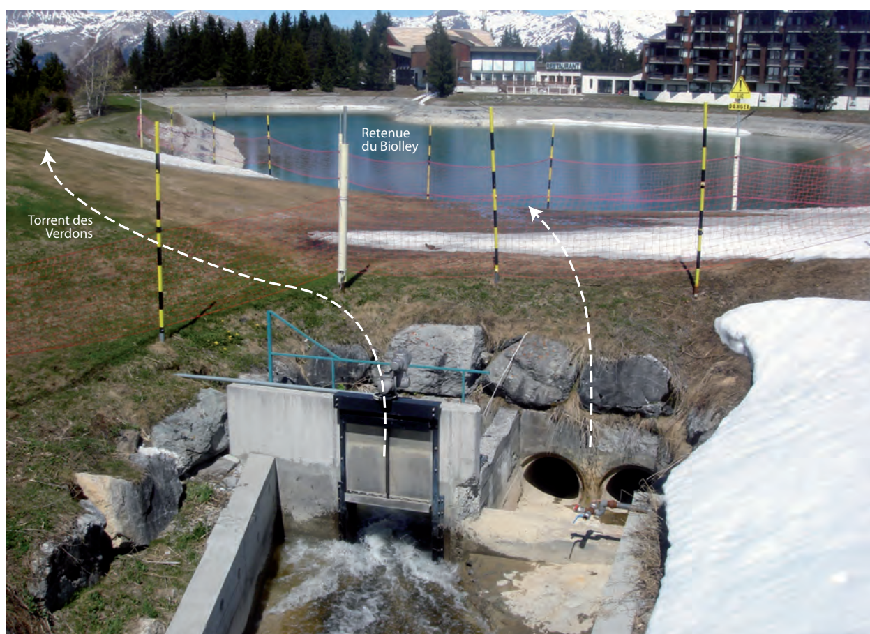
Photo 7.5 : La retenue du Biolley et son dispositif d'alimentation en eau (cliché : P. Paccard, le 07/05/2009). Une vanne permet de dériver une partie de l'eau du torrent des Verdons vers l'ouvrage ; un dispositif de cale permet de garantir le débit réservé du cours d'eau. A partir de ce point, le torrent des Verdons est en grande partie busé et s'écoule de façon souterraine jusqu'à Courchevel 1850.
