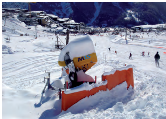
Photo 5.5 : Enneigeur monofluide mobile, installé à proximité du front de neige de la station (clichés : P. Paccard, le 25/01/2009)
