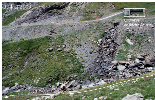
Photo 5.14 et 5.15 : Le trop-plein de la chambre de répartition de Roche-Rousse en été et en hiver (clichés : P. Paccard). Lorsque celui-ci est actif, il vient soutenir les débits du torrent de Galléron. Cette appréciation qualitative ne peut être néanmoins mesurée quantitativement faute de données disponibles.
