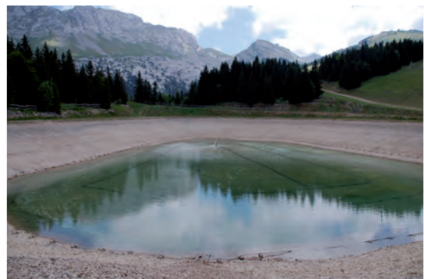
Photo 6.11 : La retenue du Pré des Preys en période de remplissage (cliché : P. Paccard, le 30/06/2009). Il s'agit ici d'un remplissage de l'ouvrage après vidange pour entretien décennal.
