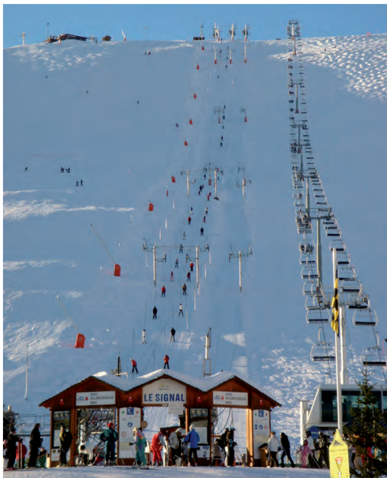
Photo 3.9 : Une ligne d'enneigeurs (10 perches, à gauche) pour deux téléskis et un télésiège débrayable 6 places à l'Alpe d'Huez, Isère, France (cliché : P. Paccard, janvier 2009). La production de neige peut permettre l'exploitation de l'ensemble de ces appareils même lorsque l'enneigement est globalement déficitaire.
