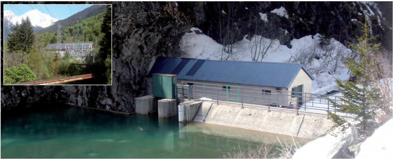
Photo 7.17 : Le barrage communal de La Rosière (cliché : P. Paccard, le 03/04/2009). Juste à l'aval du barrage, le bâtiment prise d'eau d'EDF ; c'est de là que partent les eaux de La Rosière pour être turbinées à la centrale hydroélectrique de Bozel, en médaillon (en haut à gauche ; cliché : P. Paccard, le 07/05/2009).
