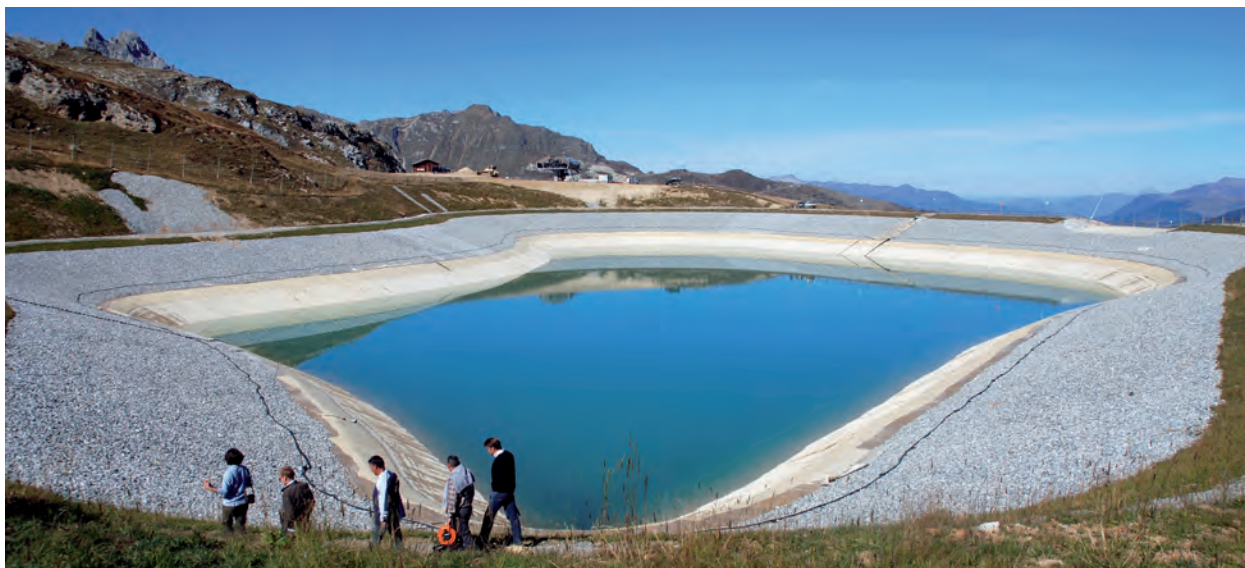
Photo 7.10 : La retenue de l'Ariondaz : 131 000 m 3 à 2170 m d'altitude (cliché : P. Paccard, le 29/09/2009)
