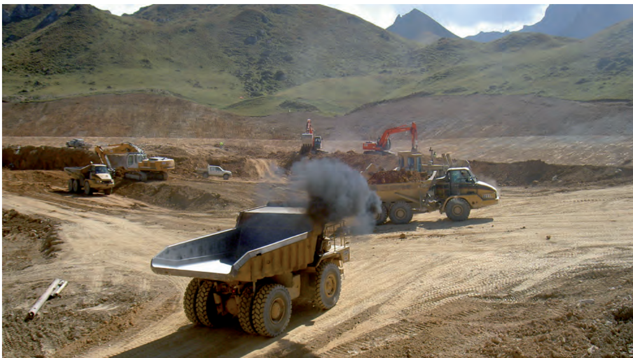
Photo 7.12 : Les travaux de terrassement de la retenue de l'Ariondaz (cliché, DDAF de la Savoie, le 12/09/2007). La réalisation d'une retenue d'altitude est un énorme chantier ; ici, un tombereau à « pleins poumons ». Interrompu plus de 30 jours pour cause d'intempéries, celui de l'Ariondaz a duré 5 mois ; la première mise en eau de l'ouvrage s'est faite au mois de novembre 2007.
