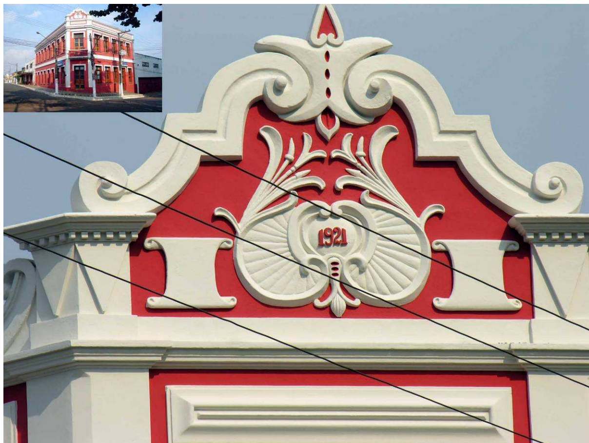
Comme sa façade l'indique, ce commerce a été fondé en 1921, après la chute des cours du caoutchouc. Le bâtiment, restauré, abrite aujourd'hui les services de l'INSS, la sécurité sociale. Photo Hervé Théry, 2005
