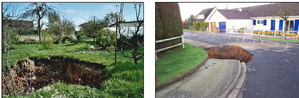
Figure VI.2 : Effondrements de la provoqués par les marnières.
