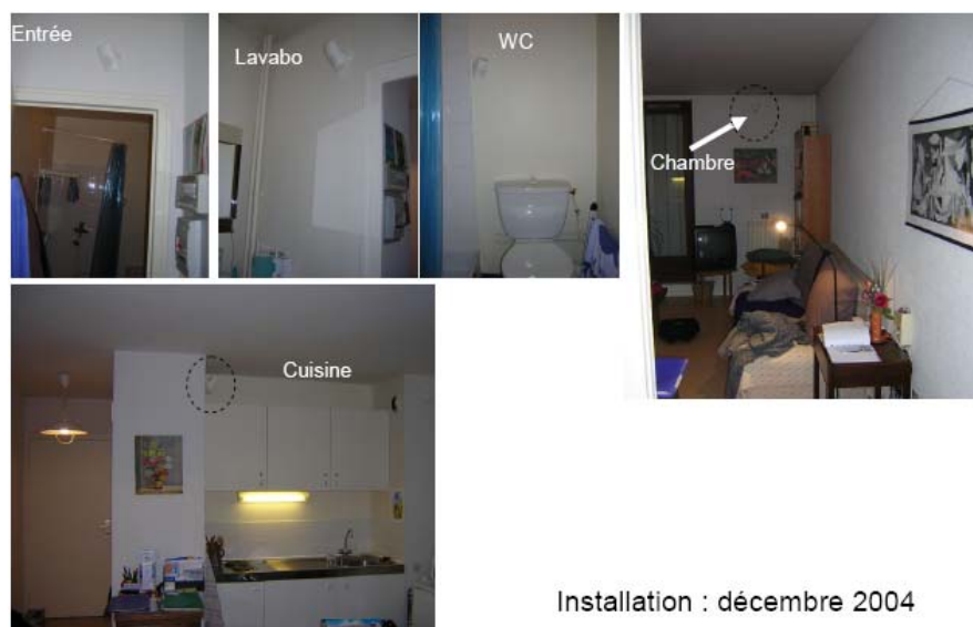
Figure 2-3 - Installation des capteurs dans un appartement
