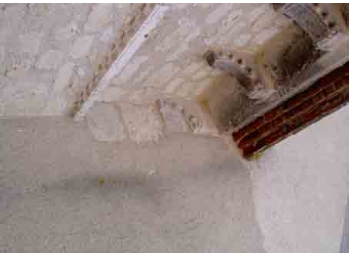
Fig. 216 - Mehun-sur-Yèvre, église Notre-Dame. Pignon du sanctuaire, face orientale, côté nord, détail de modillons à copeaux de la corniche de l'abside.
