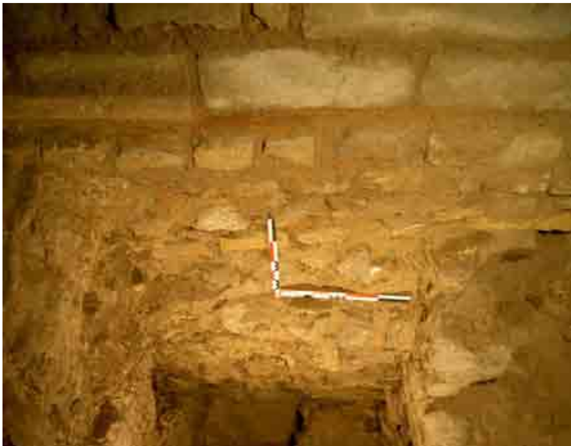
Fig. 13 - Orléans, église Saint-Aignan. Crypte, couloir sud, secteur 1 : murs de fondation US 6015 et 6017 (cl. C. Arnaud).
