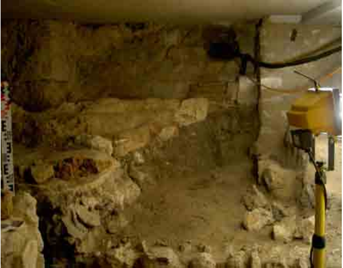
Fig. 334 - Châteaudun, église de la Madeleine. Sous-sol archéologique, collatéral nord, mur sud du clocher, côté est.
