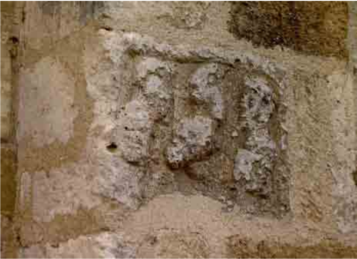
Fig. 203 - Mehun-sur-Yèvre, église Notre-Dame. Nef, mur sud (extérieur), contrefort séparant les deux dernières travées, détail d'un rempli de sarcophage sculpté.
