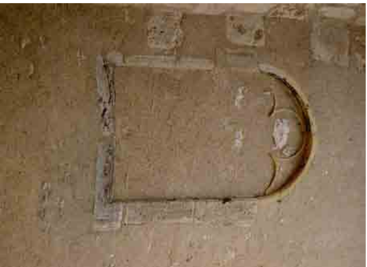
Fig. 232 - Mehun-sur-Yèvre, église Notre-Dame. Chapelle axiale, détail extérieur d'une baie gothique condamnée.
