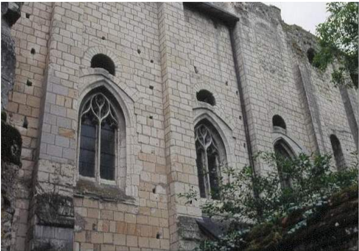
Fig. 118 - Beaulieu-lès-Loches, église de La Trinité. Nef, côté nord (travées 7, 8, 9).
