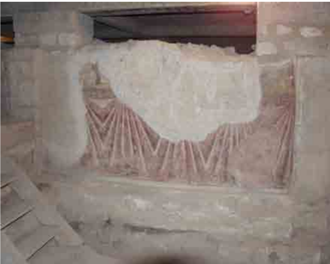
Fig. 305 - Châteaudun, église de la Madeleine. Sous-sol archéologique, abside, face est (extérieur), peintures murales.
