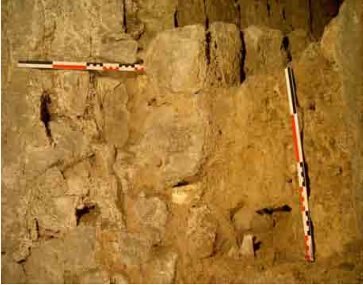
Fig. 17 - Orléans, église Saint-Aignan. Crypte, couloir sud, secteur 3 : maçonneries US 6001 et 6003 (cl. C. Arnaud).
