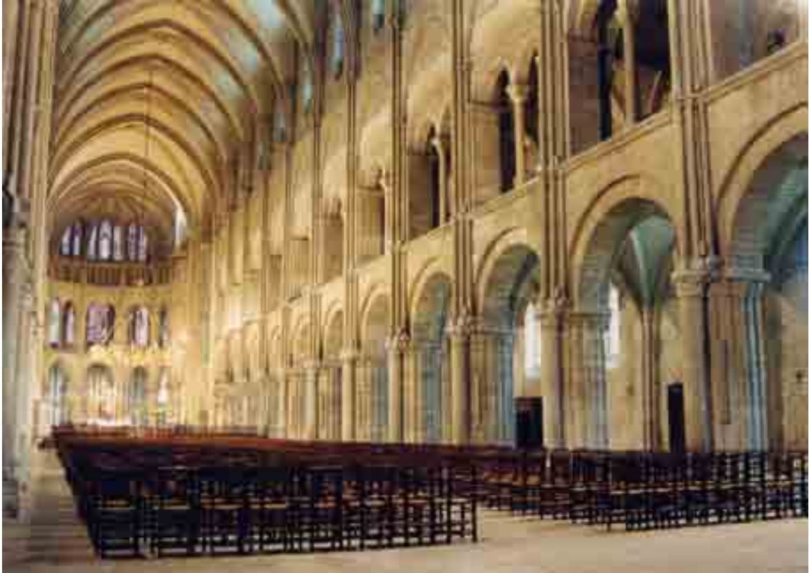
Fig. 117 - Reims, église Saint-Remi. Vue générale intérieure vers le sud-est.
