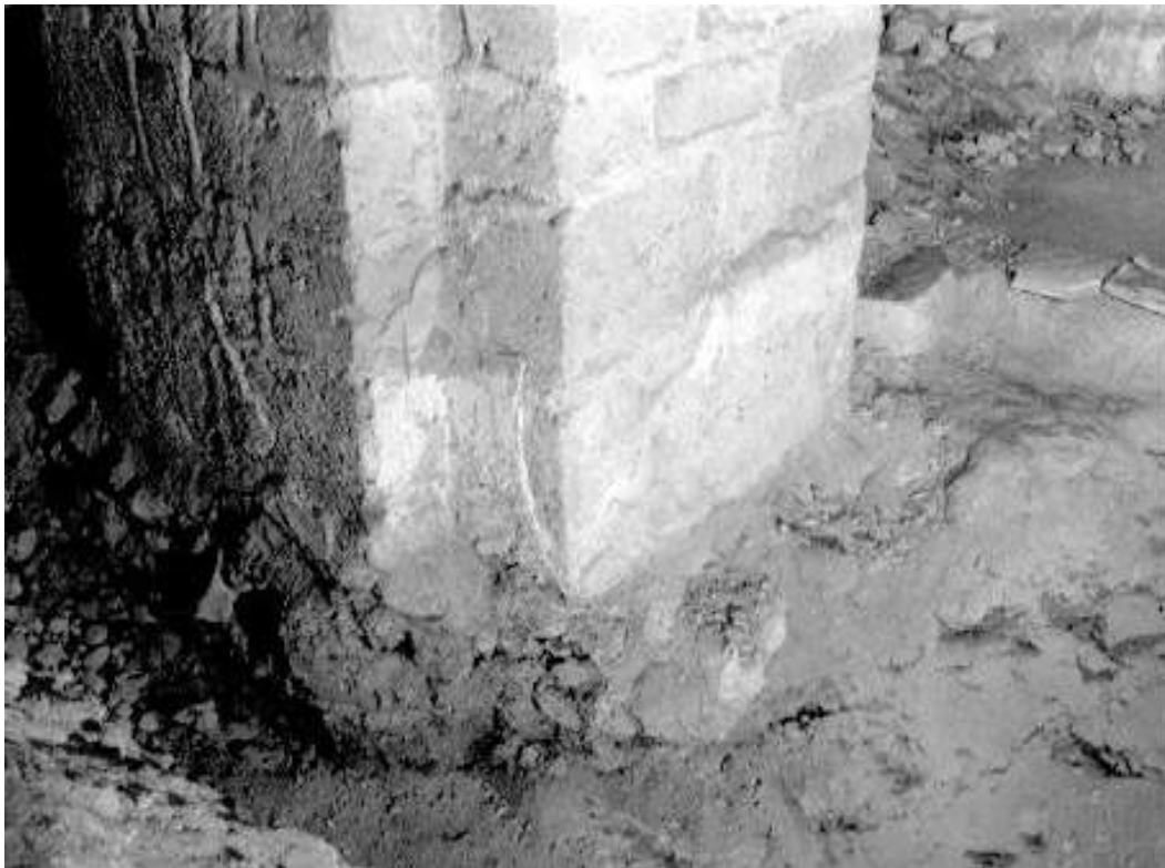
Fig. 62 - Orléans, église Saint-Aignan. Crypte, salle centrale, sondage du Dr Lesueur : fondation des piliers de l'abside (cl. Désir, 17 déc. 1954).
