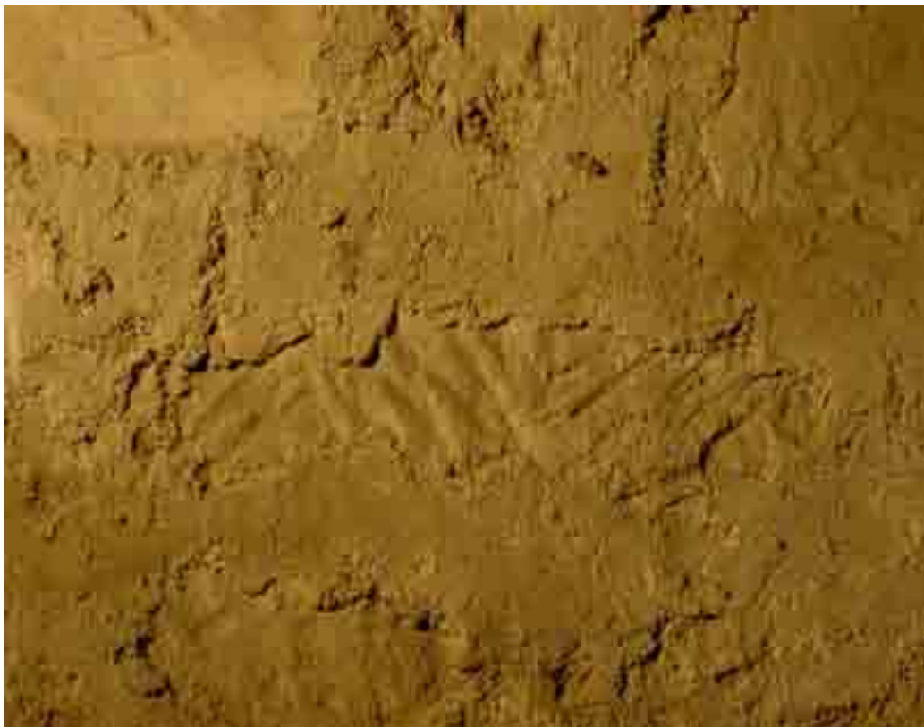
Fig. 108 - Tours, basilique Saint- Martin. Crypte, vestiges de la chapelle axiale, fondation (US 1003), détail de traces d'outils : pic ou broche.
