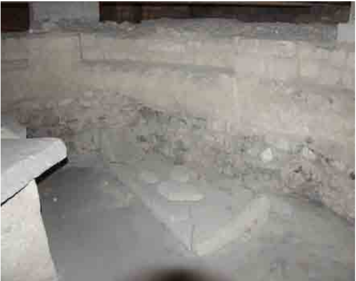
Fig. 299 - Châteaudun, église de la Madeleine. Sous-sol archéologique, abside, côté sud (intérieur), fondations.
