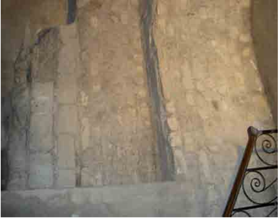
Fig. 106 - Tours, basilique Saint-Martin. Crypte, vestiges de la chapelle axiale, côté nord.
