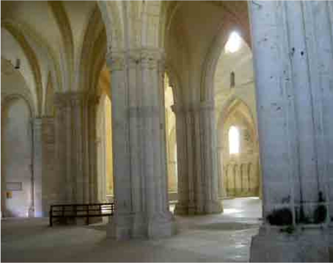
Fig. 363 - Châteaudun, église de la Madeleine. Collatéraux nord de la nef.
