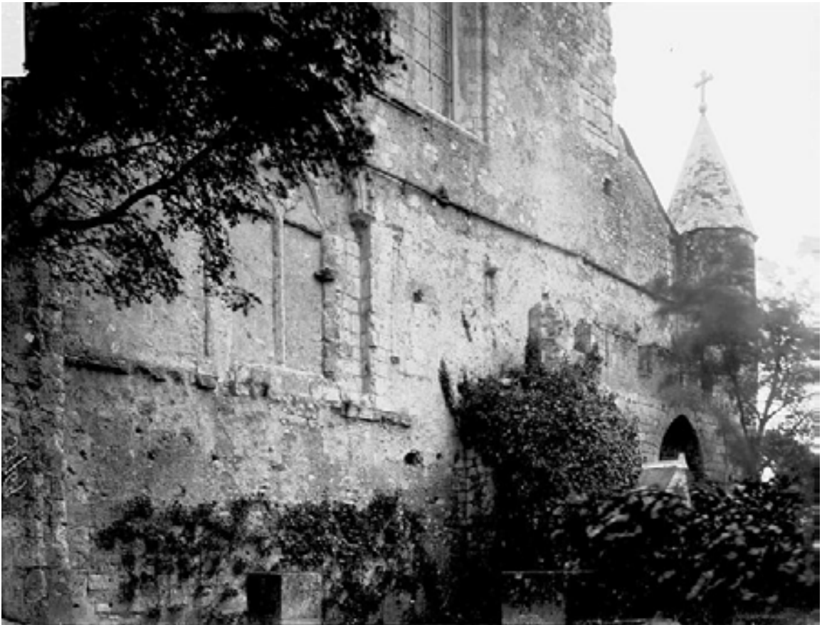
Fig. 361 - Châteaudun, église de la Madeleine. Côté ouest : pignon. Méd. Patrimoine cl. sap01_mh033769_p (C. Enlart, s.d.).
