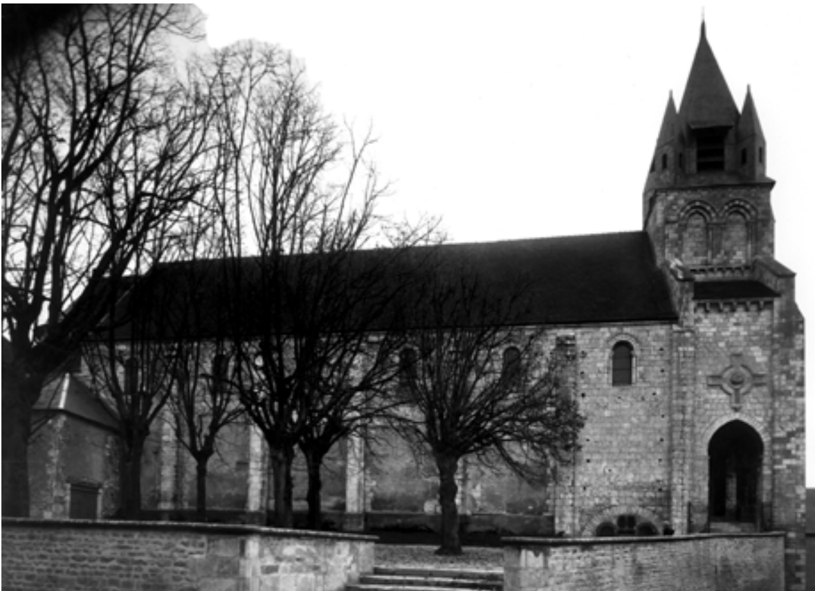
Fig. 174 - Mehun-sur-Yèvre, église Notre-Dame. Ensemble nord. Cl. Méd. patrimoine MH0097065 (G. Estève, avant 1932).
