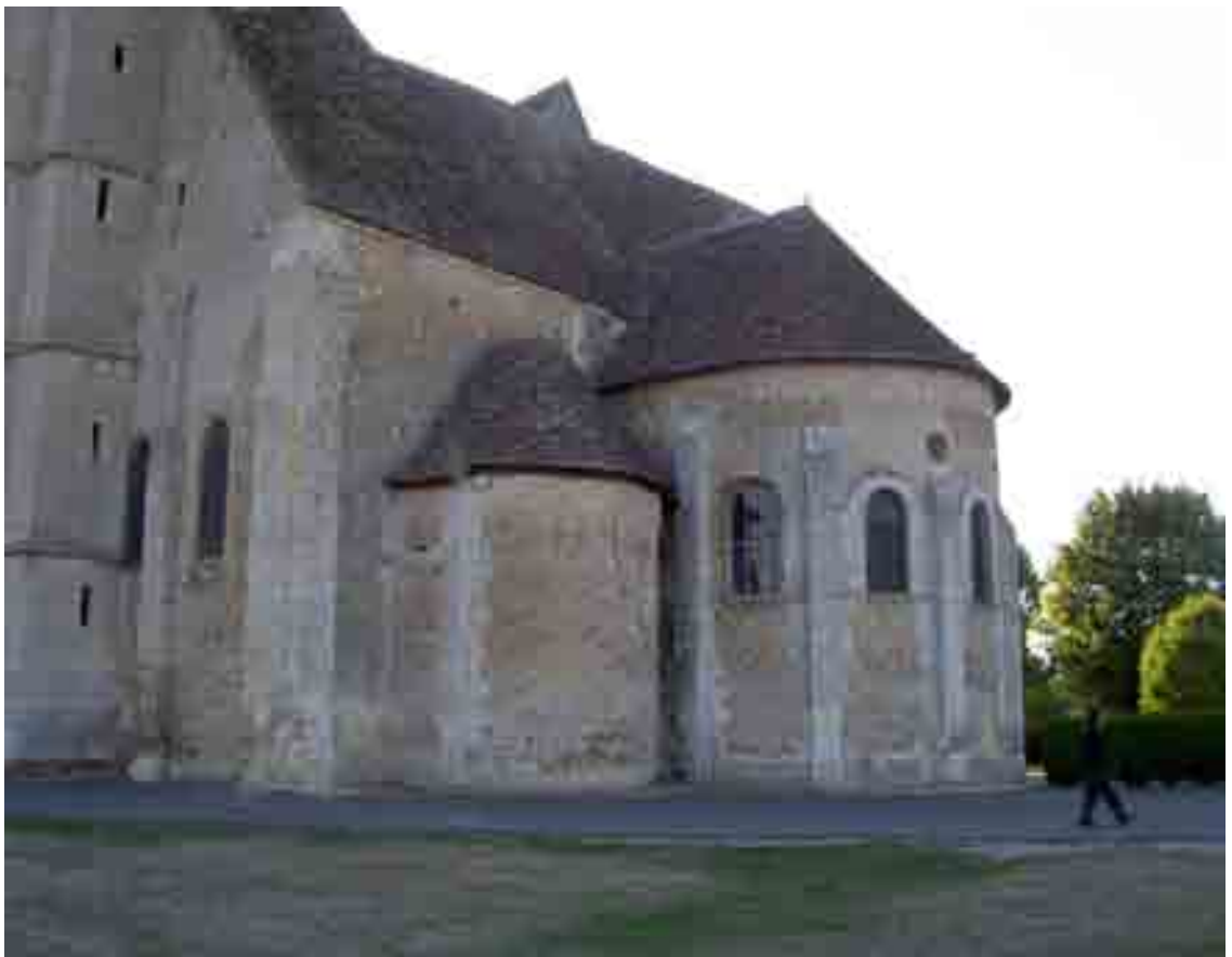
Fig. 347 - Châteaudun, église Saint-Jean-de-la-Chaine. Chevet vu du sud-est.
