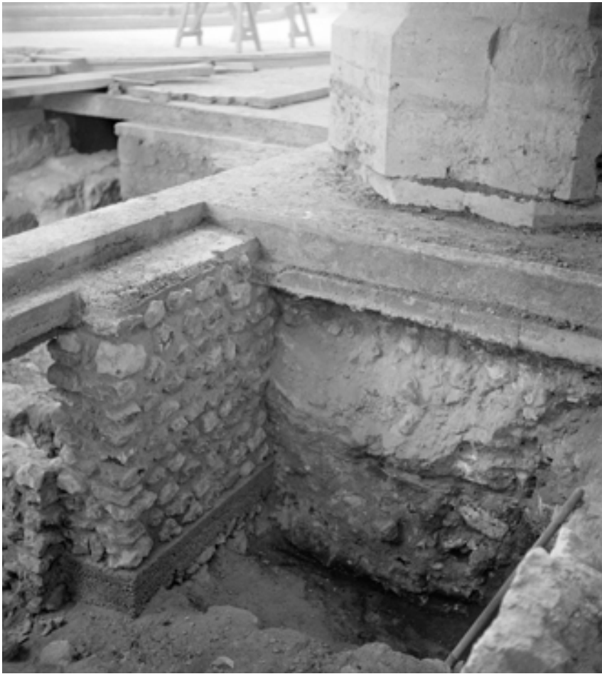
◀ Fig. 340 - Châteaudun, église de la Madeleine. Quatrième pilier gothique, côté nord, fondation (refait en 1692), vue vers le sud au cours de la construction de la dalle du sous-sol archéologique. Méd. Patrimoine, 16 L 03214 (Fonds Trouvelot, 1958- 1959).
