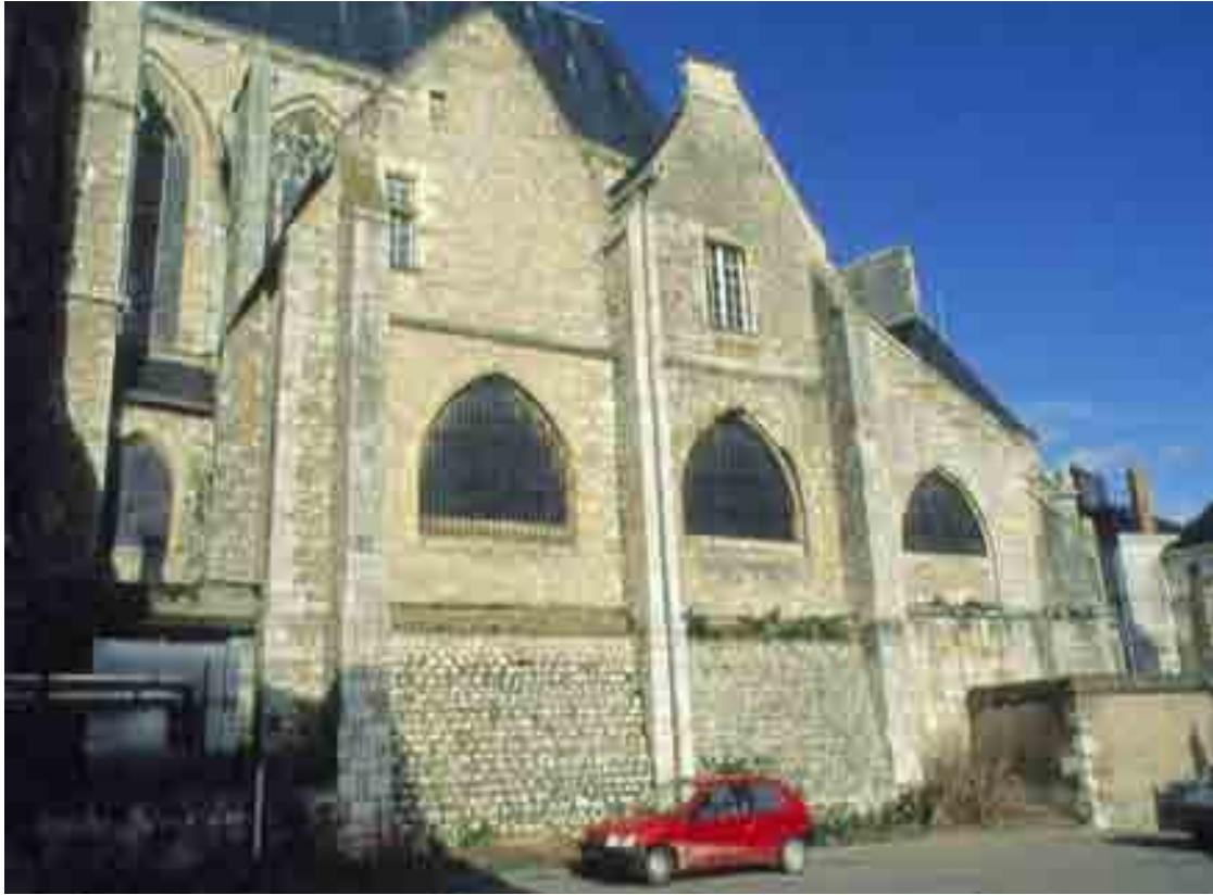
Fig. 76 - Orléans, église Saint-Aignan. Collégiale, sacristies vues du sud avec renforcement des parties inférieures.
