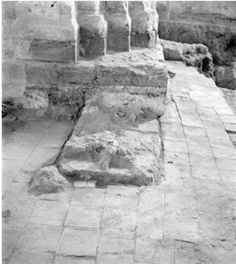
Fig. 359 - Châteaudun, église de la Madeleine. Collatéral nord de la nef, niveau de dallage de terre cuite, vue vers l'ouest. Au premier plan, première pile (arasée) des grandes arcades, côté nord (?). Au second plan, fondation du premier pilier gothique, côté nord. Méd. Patrimoine, 16 L 03268 (Fonds Trouvelot, 1958-1959).
