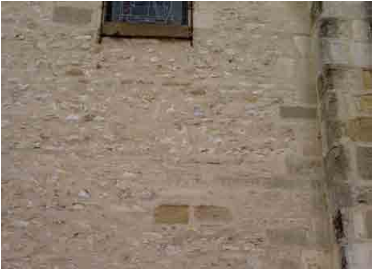
Fig. 201 - Mehun-sur-Yèvre, église Notre-Dame. Nef, mur sud (extérieur), quatrième travée, détail de l'appareillage.
