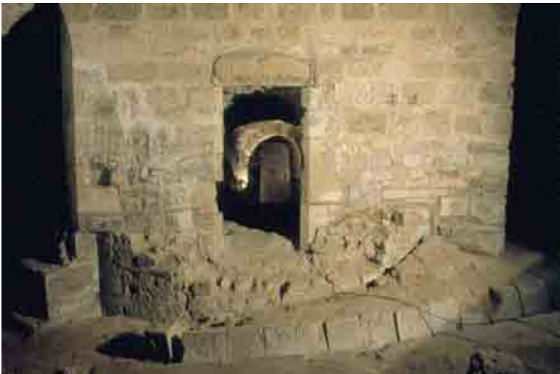
Fig. 49 - Orléans, église Saint-Aignan. Crypte, chapelle axiale, mur plat réaménagé sur l'absidiole.
