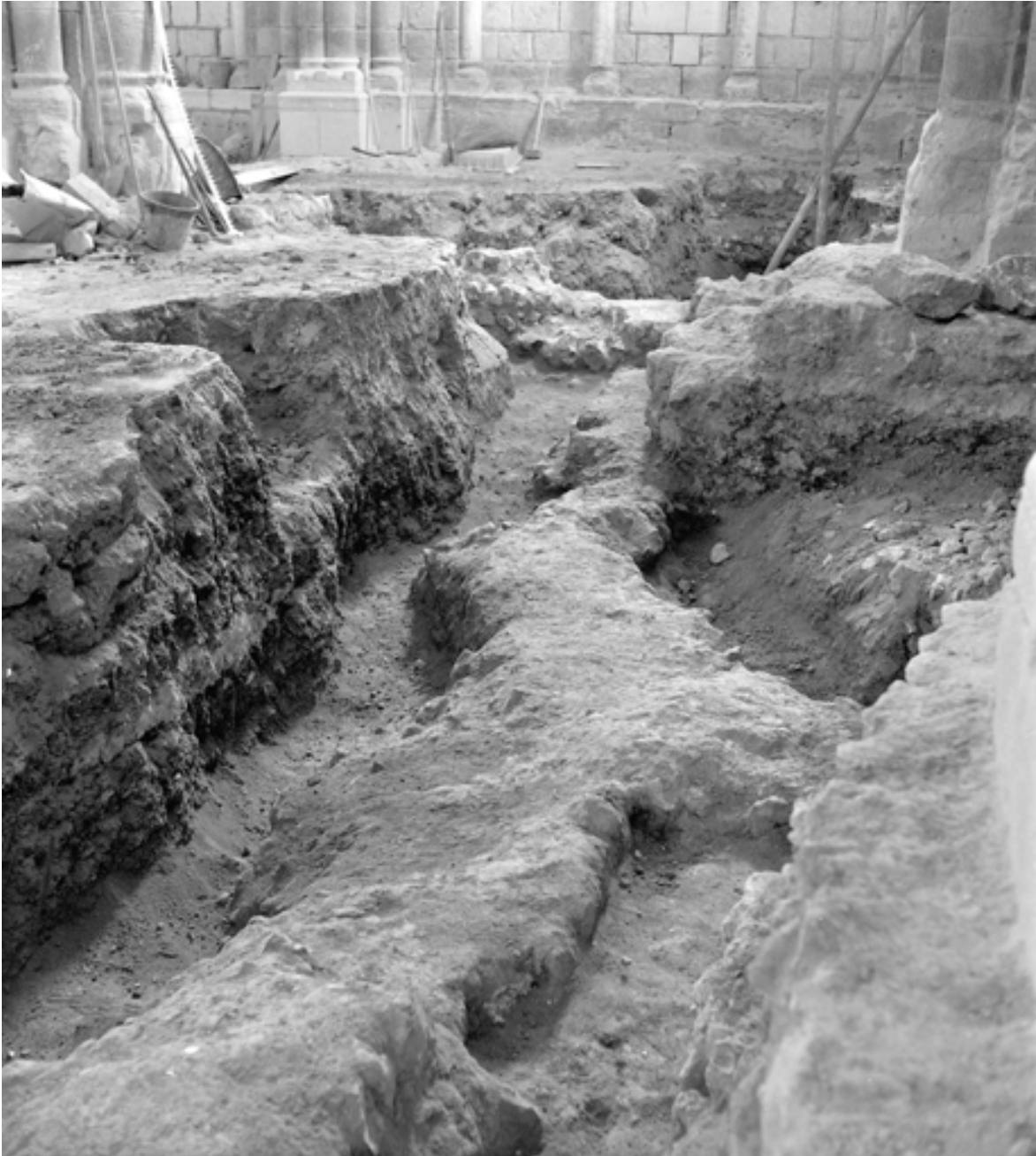
Fig. 353 - Châteaudun, église de la Madeleine. Annexe nord de la nef, maçonnerie ouest-est et mur ouest, vue vers l'ouest. Au premier plan, abside (?). Méd. Patrimoine, 16 L 03375 (Fonds Trouvelot, 1958-1959).
