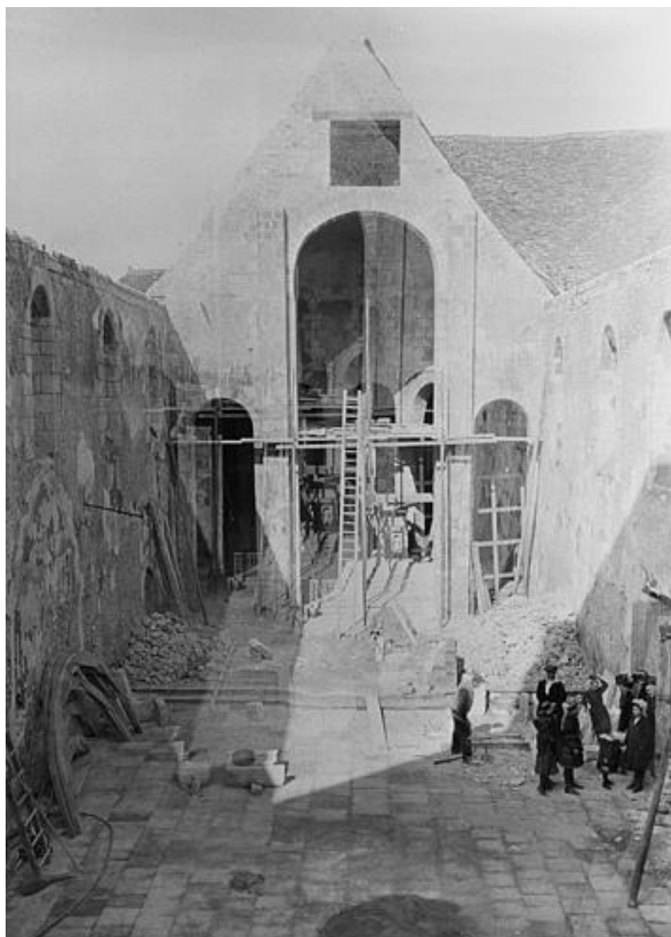
Fig. 171 - Mehun-sur-Yèvre, église Notre-Dame. La nef en cours de restauration. Cl. Méd. patrimoine 10L06591 (L. Roy, avril 1912).
