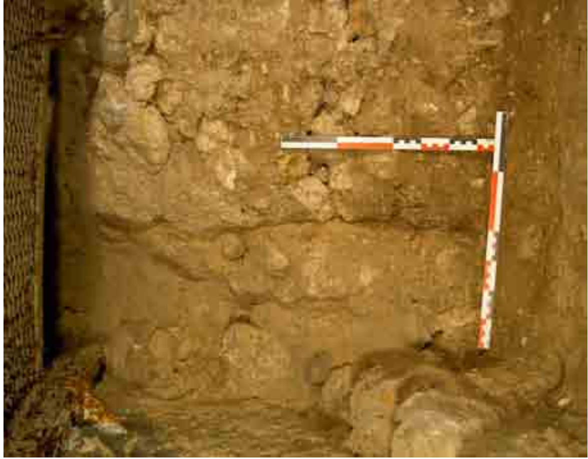
Fig. 16 - Orléans, église Saint-Aignan. Crypte, couloir sud, secteur 3 : maçonneries US 6002 et 6005 (cl. C. Arnaud).
