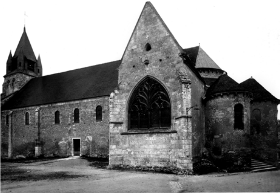
Fig. 173 - Mehun-sur-Yèvre, église Notre-Dame. Ensemble sud-est. Cl. Méd. patrimoine MH0097064 (G. Estève, avant 1932).
