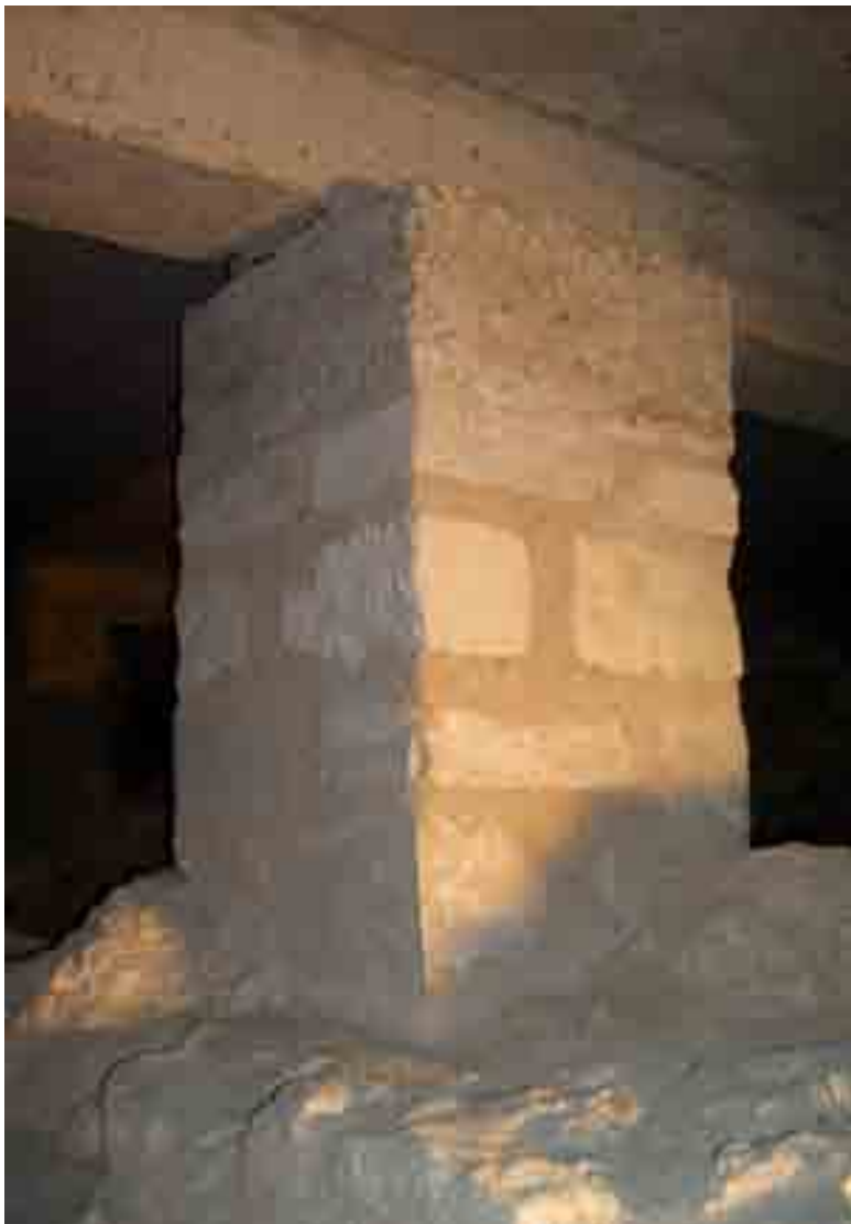
Fig. 322 - Châteaudun, église de la Madeleine. Sous-sol archéologique, fondation (23004) de l'abside du XVI e siècle, côté nord-est. Détail : carreaux de terre cuite dans un radier sur la chapelle axiale.
