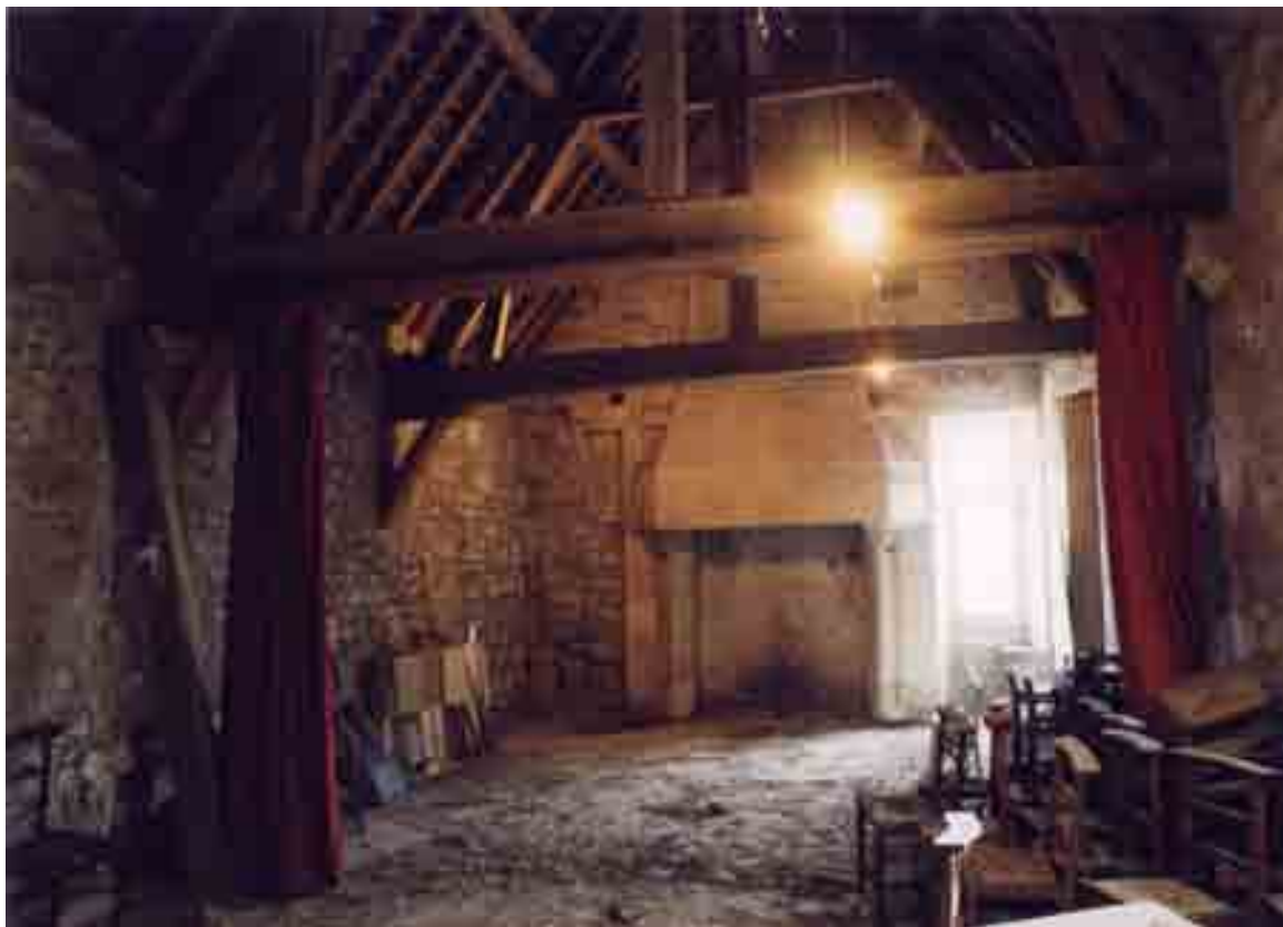
Fig. 78 - Orléans, église Saint-Aignan. Collégiale, sacristie occidentale, second niveau, cheminée du mur sud.
