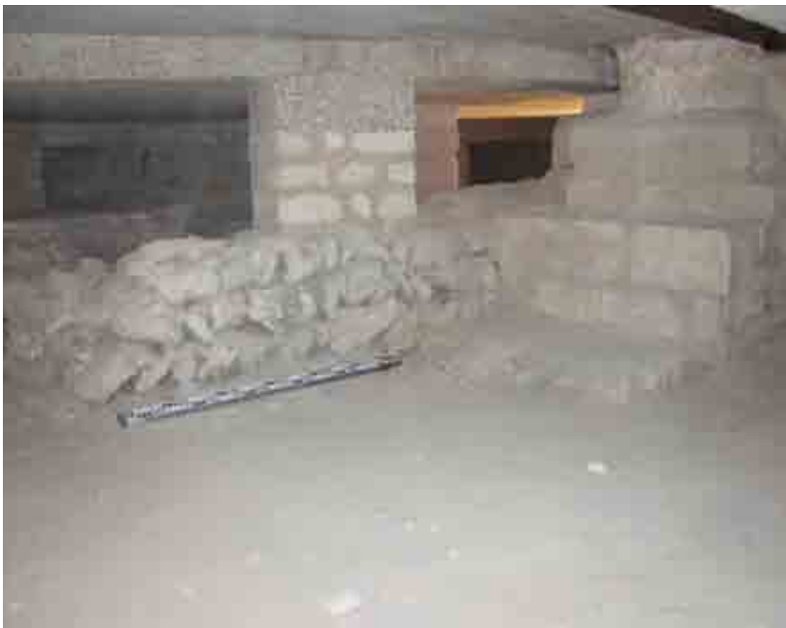
Fig. 294 - Châteaudun, église de la Madeleine. Sous-sol archéologique, mur en opus spicatum (face est) délimitant les espaces I et IV.
