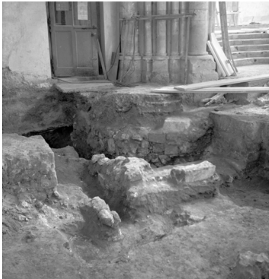
▶ Fig. 341 - Châteaudun, église de la Madeleine. Collatéral nord du chœur, emmarchements successifs d'entrée (descente), vue sud-est. Méd. Patrimoine, 16 L 03183 (Fonds Trouvelot, 1958- 1959).
