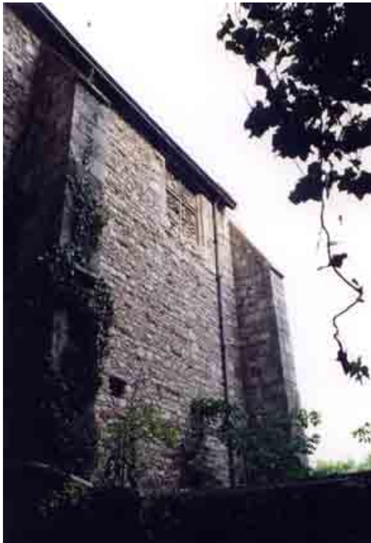
Fig. 76 - Orléans, église Saint-Aignan. Collégiale, sacristies vues du sud avec renforcement des parties inférieures.
