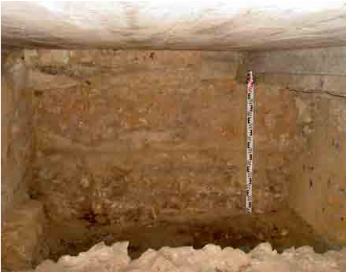
Fig. 333 - Châteaudun, église de la Madeleine. Sous-sol archéologique, collatéral nord, mur sud du clocher, côté ouest.
