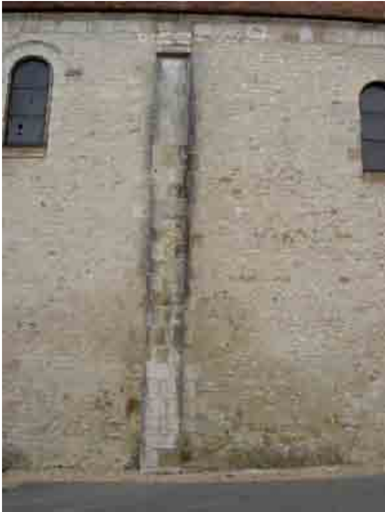
◀ Fig. 233 - Mehun-sur-Yèvre, église Notre-Dame. Nef, mur sud (extérieur), contrefort séparant les deuxième et troisième travées.
