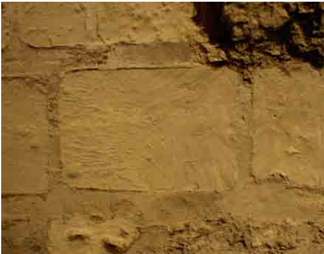
Fig. 112 - Tours, basilique Saint-Martin. Crypte, vestiges de la chapelle axiale, élévation (US 1001), détail de traces d'outils : ciseau.
