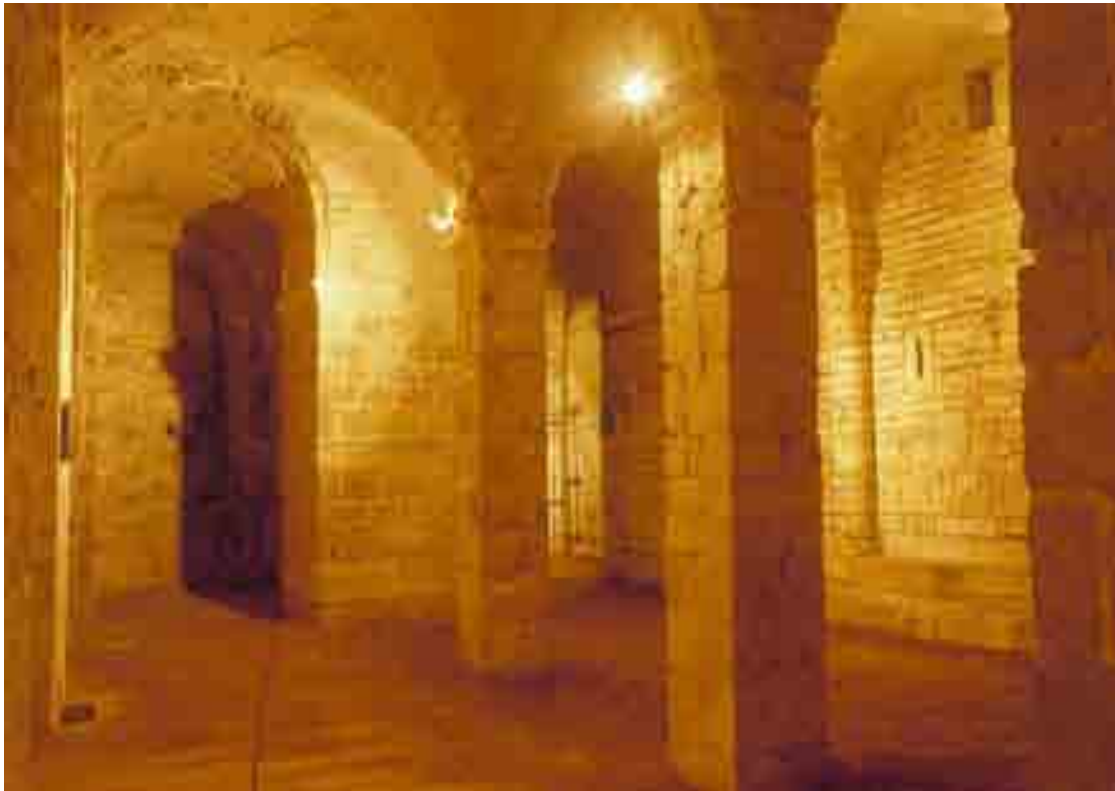
▲ Fig. 42 - Orléans, église Saint-Aignan. Crypte, salle centrale vue vers le sud-ouest.
