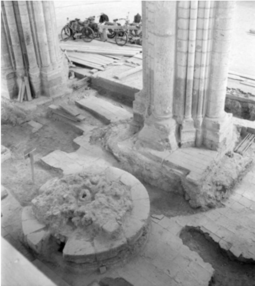
◀ Fig. 365 - Châteaudun, église de la Madeleine. Collatéral nord de la nef, vue générale des fouilles vers le sud-est avec fonts baptismaux (?) et niveau de dallage de terre cuite. Méd. Patrimoine, 16 L 03359 (Fonds Trouvelot, 1958-1959).
