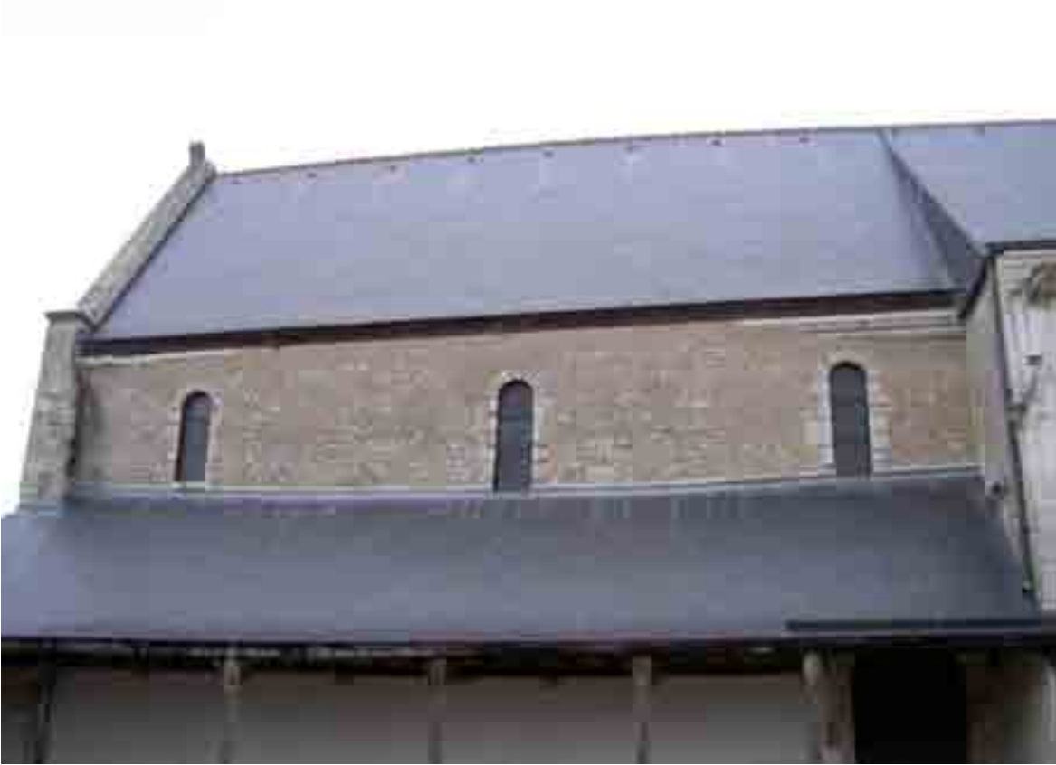
Fig. 235 - Suèvres, église Saint-Christophe. Nef, mur sud (extérieur).
