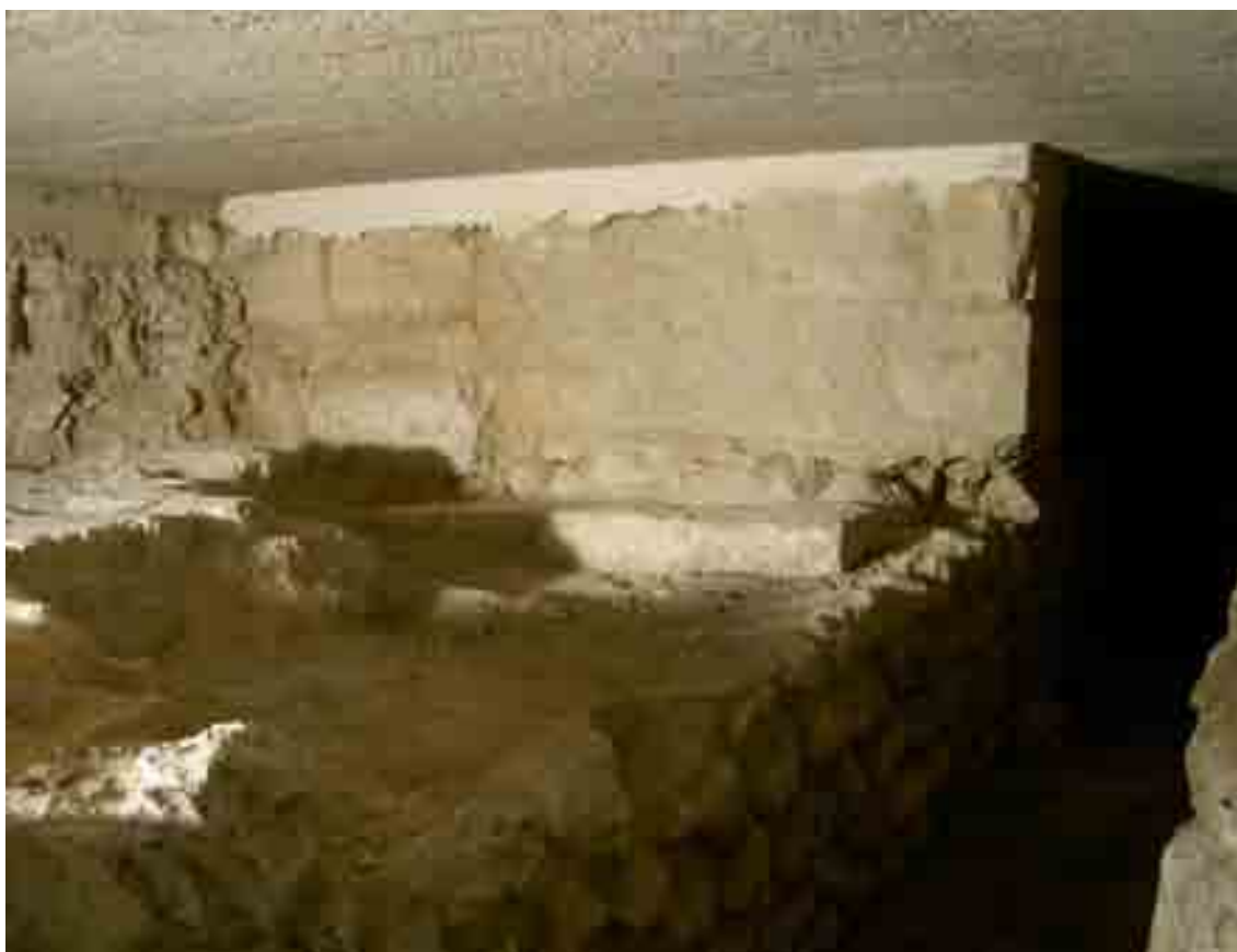
Fig. 345 - Châteaudun, église de la Madeleine. Sous-sol archéologique, pilier de la dernière travée de la nef, côté nord (PIL 401).
