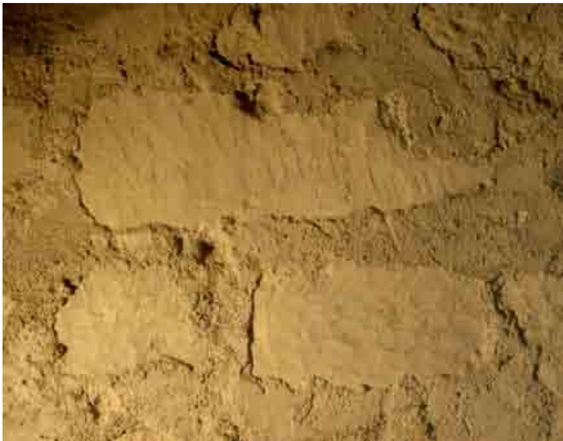
Fig. 110 - Tours, basilique Saint-Martin. Crypte, vestiges de la chapelle axiale, fondation (US 1003), détail de traces d'outils : ciseau et polka.
