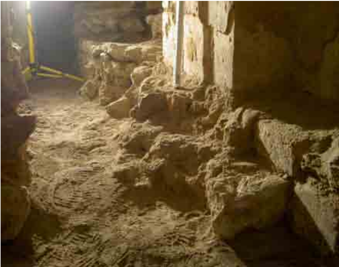
Fig. 332 - Châteaudun, église de la Madeleine. Sous-sol archéologique, collatéral nord du chœur, vue vers l'ouest.
