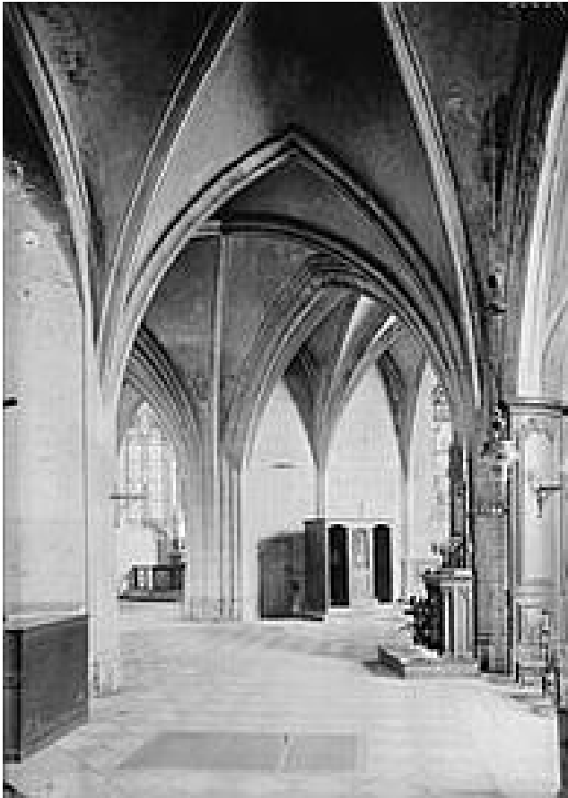
◀ Fig. 82 - Orléans, église Saint-Aignan. Collégiale, déambulatoire et chapelle rayonnante nord en 1923. Cl. sap01_mh072512_t.
