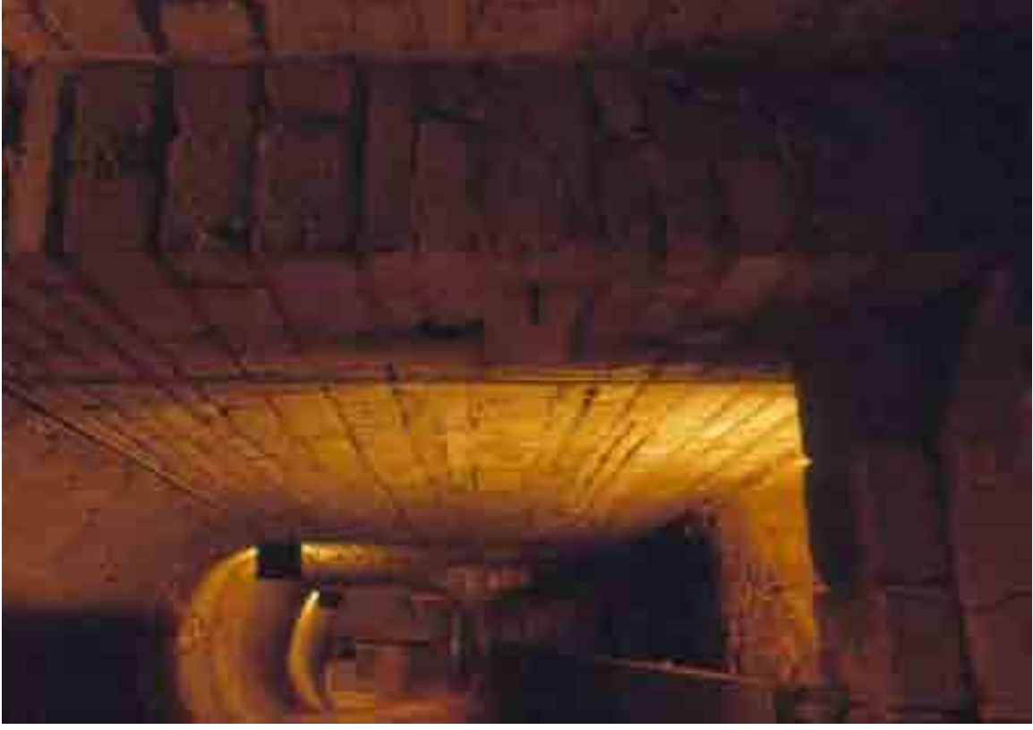
Fig. 21 - Orléans, église Saint-Aignan. Crypte, couloir sud, mur nord vu vers l'ouest.
