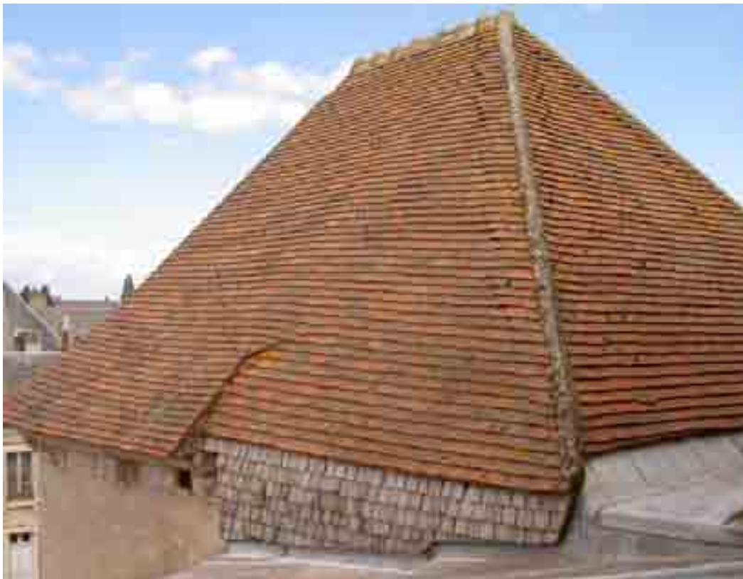
Fig. 226 - Mehun-sur-Yèvre, église Notre-Dame. Chapelle rayonnante nord, couverture vue vers l'est.
