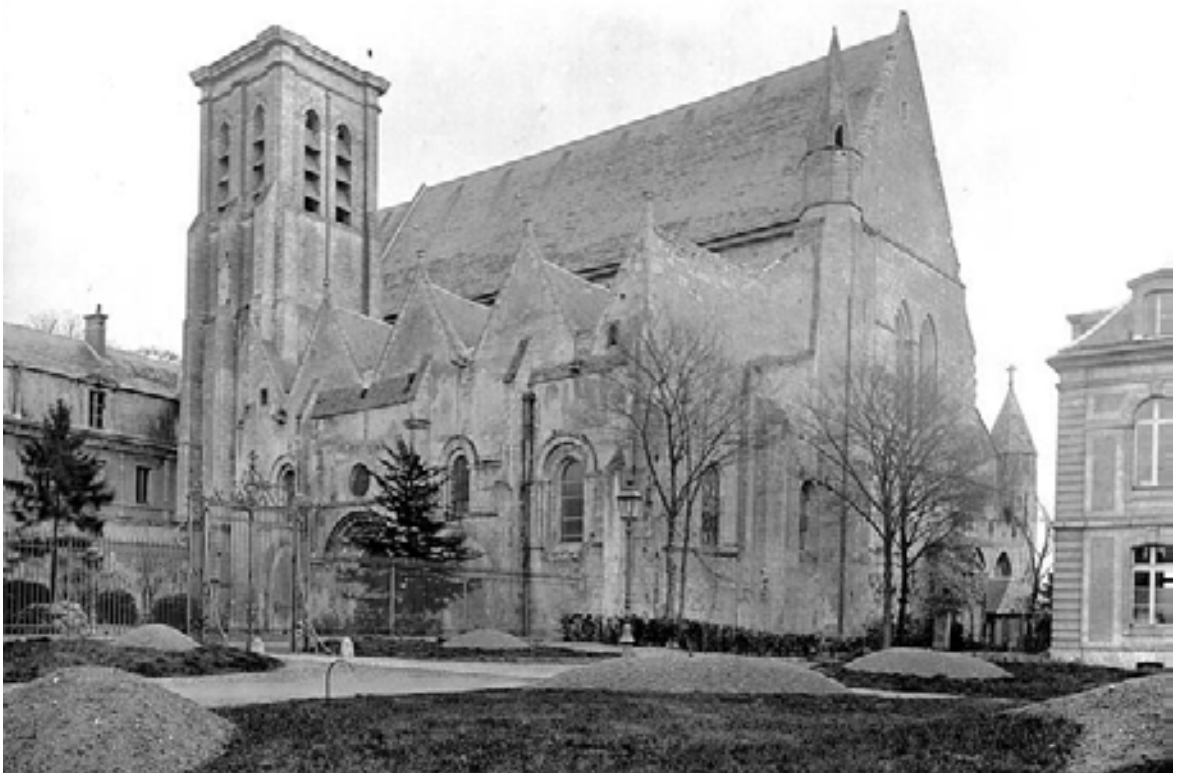
Fig. 287 - Châteaudun, église de la Madeleine. Ensemble nord-ouest. Méd. Patrimoine cl. sap01_mh051525_p (F. Martin-Sabon, 1906).
