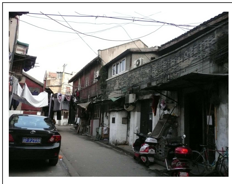
Photo 4. La maison d'un gérant d'une équipe de démolition (à la droite) et sa voiture
