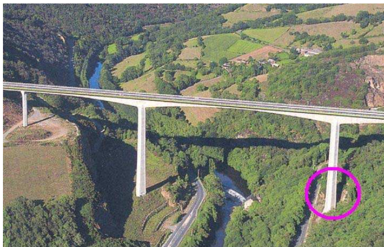
Figure 56 : Photo du Viaduc sur le Viaur.
