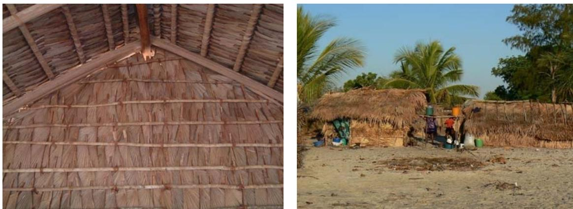
**Photographie 44 : A Ampasimaloatra, comblement de l'espace entrant – faitage à l'aide d'assemblages de demi-feuilles de *satrana***
