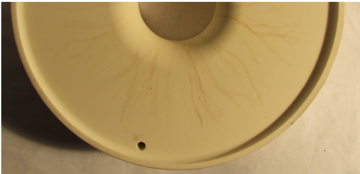
Figure 3.55. Isolant époxy ayant subi des DP et des claquages.
