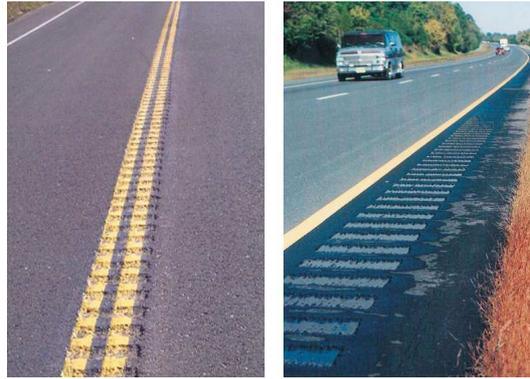
FIGURE I.1 – Bandes rugueuses en milieu et bord de voie
