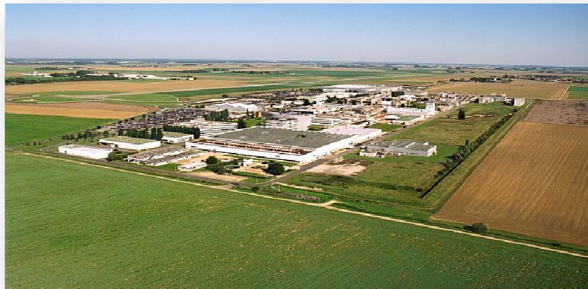
Figure C : Vue aérienne du centre aéronautique de Réau-Villaroche, 82 ha , 5000 personnes, activités de développement, essais, production, maintenance (France)
