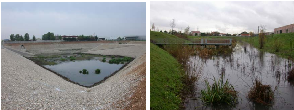
Figure 1.8: Photographies de deux bassins d'infiltration d'eau pluviale de l'Est Lyonnais (gauche : Django Reinhardt (Chassieu), droite : Minerve (St Priest)) (photo G. Bouger).
