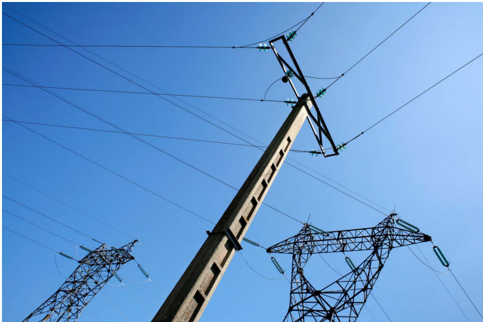
Image 59 Pylône du réseau de distribution 20 kV. Au premier plan, pylône « 3 fils » classique du réseau de distribution de 20 kV parcourant les campagnes, au départ du poste d'interconnexion de Vielmoulin. © Samuel Challéat, ThéMA, 2010.
