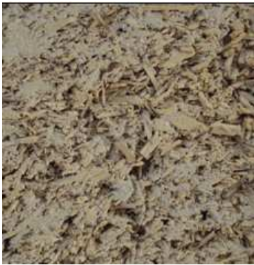
Figure a : Surface de l'échantillon 1A Chanvre-chaux
