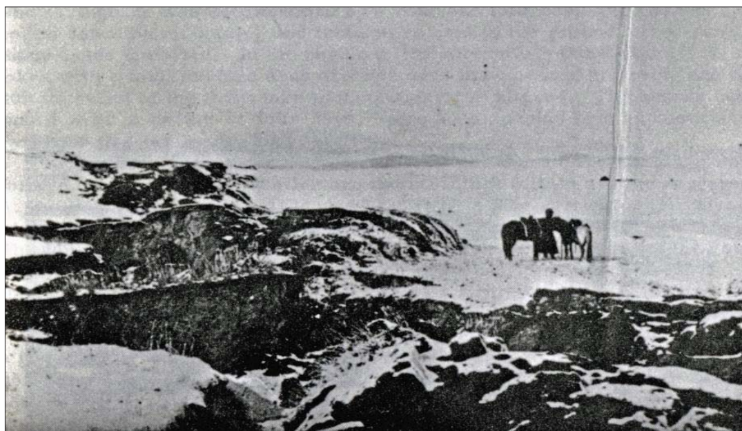
Figure III-3-2 : Photographie de la surface de rupture du séisme de Bolnay prise en 1914 par Voznesenskii.
