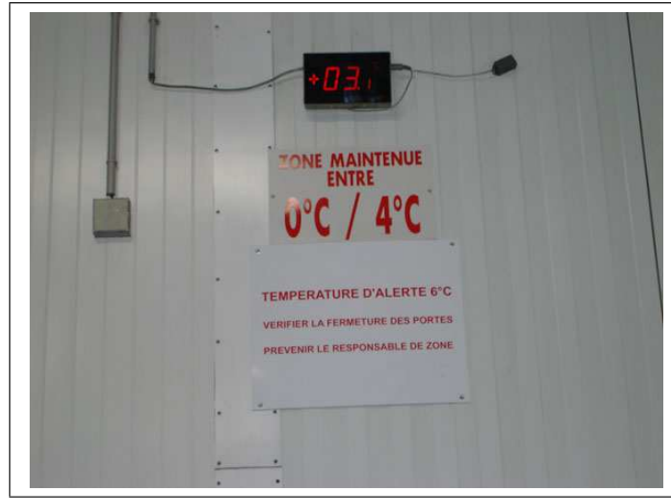
FIGURE 4.1: Afficheur mural de température ambiante de l'entrepôt muni d'un dispositif d'alarme
