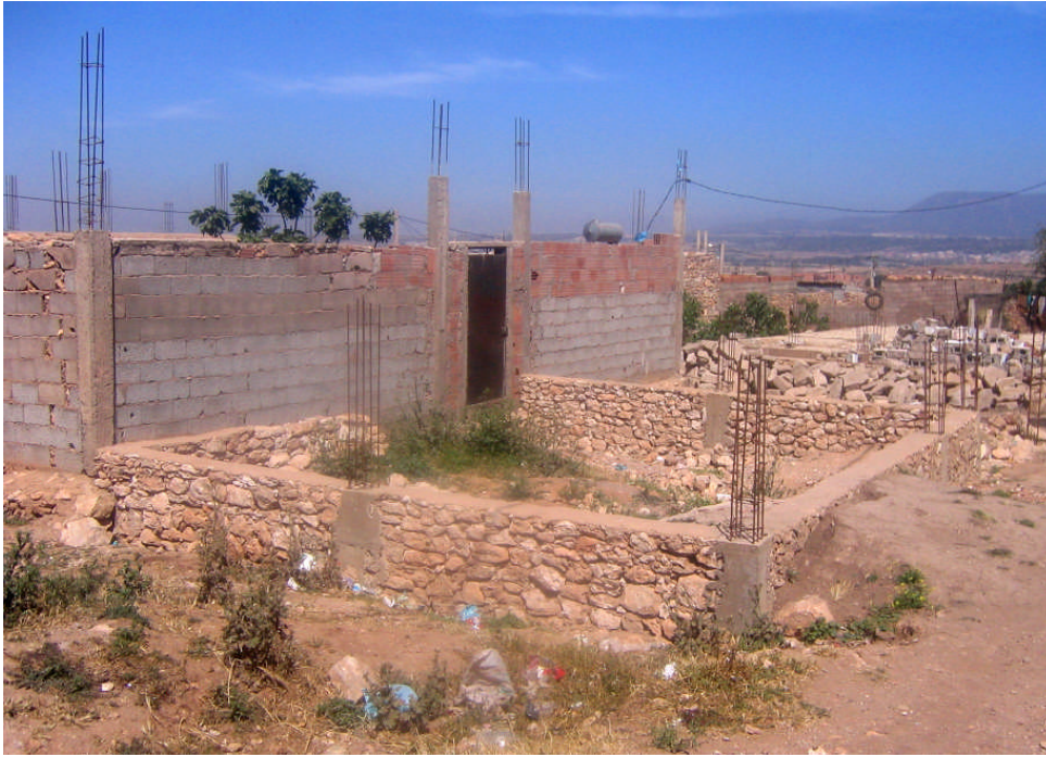
Figure 2-2 : procédé de construction pour délimiter la parcelle de terrain squattée (septembre, 2008).
