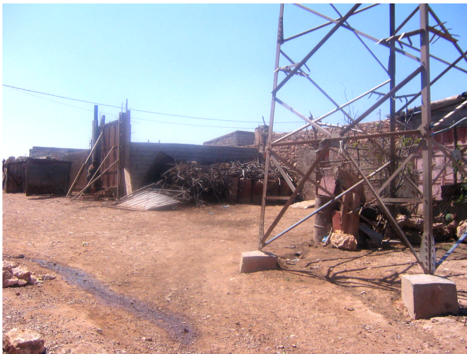
Figure 6-2 : des habitations construites à proximité d'un pylône d'électricité et le risque permanent d'électrocution à Med Boudiaf (août, 2008)
