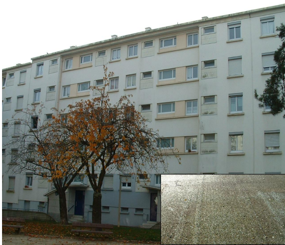
(a) Toit terrasse en bitume
