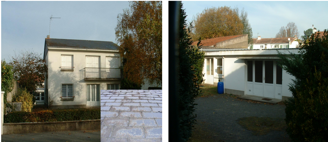
(a) Toit en ardoise
