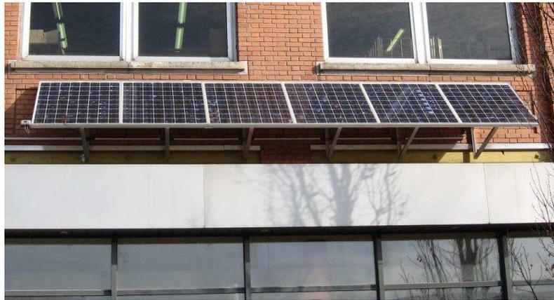
FIGURE 31. Modules photovoltaïques
