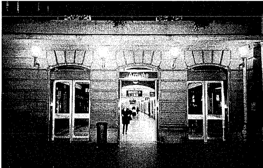
Gare SNCF de Strasbourg
