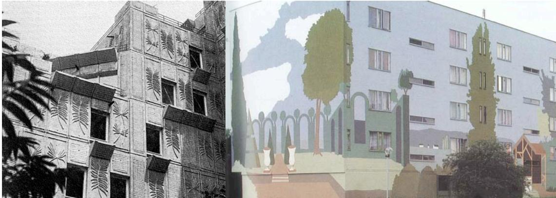
La « façade végétale » d'Evry I reproduit un dessin de fougère au moyen d'un moulage de béton - 1974<sup>121</sup>
