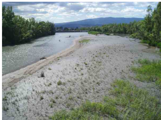
Photo 2 : Envasement du lit de la Bléone, Alpes de Haute Provence Source : Freddy Rey, Cemagref
