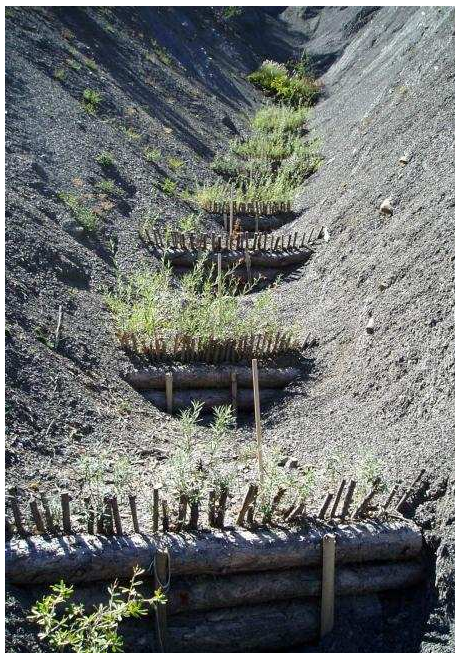
Photo 6 : Barrières végétales installées dans le lit d'une ravine (Photo Mélanie Burylo)
