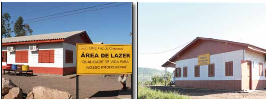
Photos 2.52 et 2.53 - À gauche une des maisons consacrées aux loisirs et à droite le bâtiment pour la médecine du travail dans l'enceinte du barrage, Águas de Chapecó/SC, le 16 juillet 2008, G. LETURCQ.
