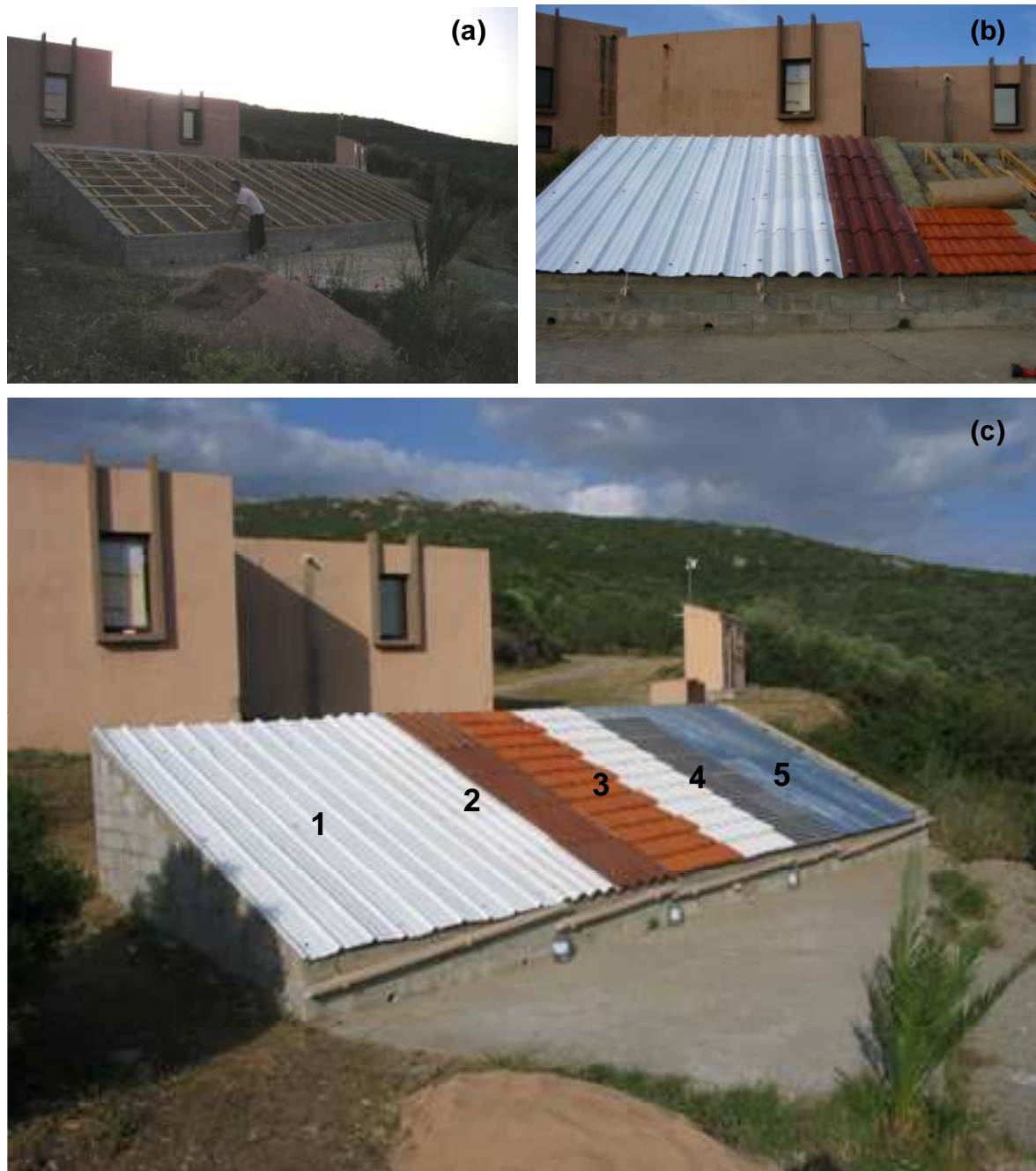
Figure I.46. Prototype 3 (40 m 2 ) construit en mai 2007 à l'Université de Corse (Ajaccio) pour une étude simultanée de l'efficacité des peintures pour la condensation de l'eau mais également pour la climatisation passive de bâtiments. (a) : construction de la charpente, (b) : dépose de l'isolant (laine de roche 70 mm), (c) : 5 natures de toitures typiques des PVD, teintes blanches pour les pays chauds en mode climatisation passive et condensation l'eau, teinte incolore pour respect de la nature du substrat et en mode condensation de vapeur d'eau.
