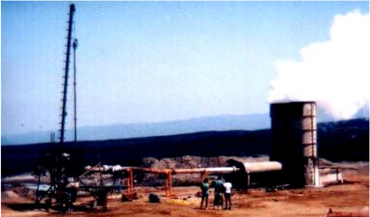
Tests de production du puit Assal 3
