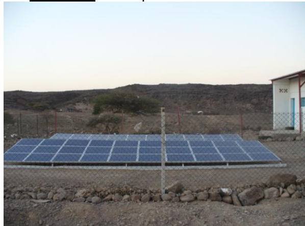
Photo 2.6 : Site après l'installation
