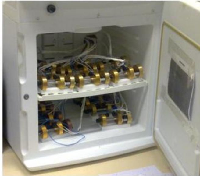
Fig.49 : Enceinte thermo-régulée contenant 16 dispositifs de mesures 4 fils
