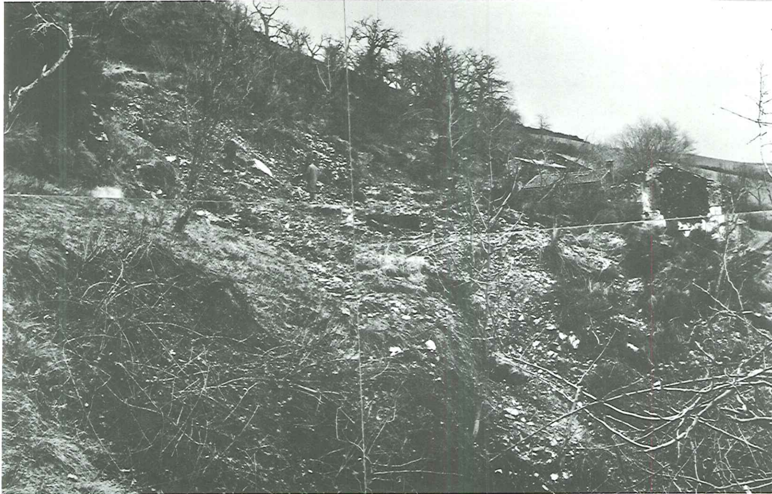
Figure 26 : Photographie latérale de la partie médiane du glissement de terrain.
