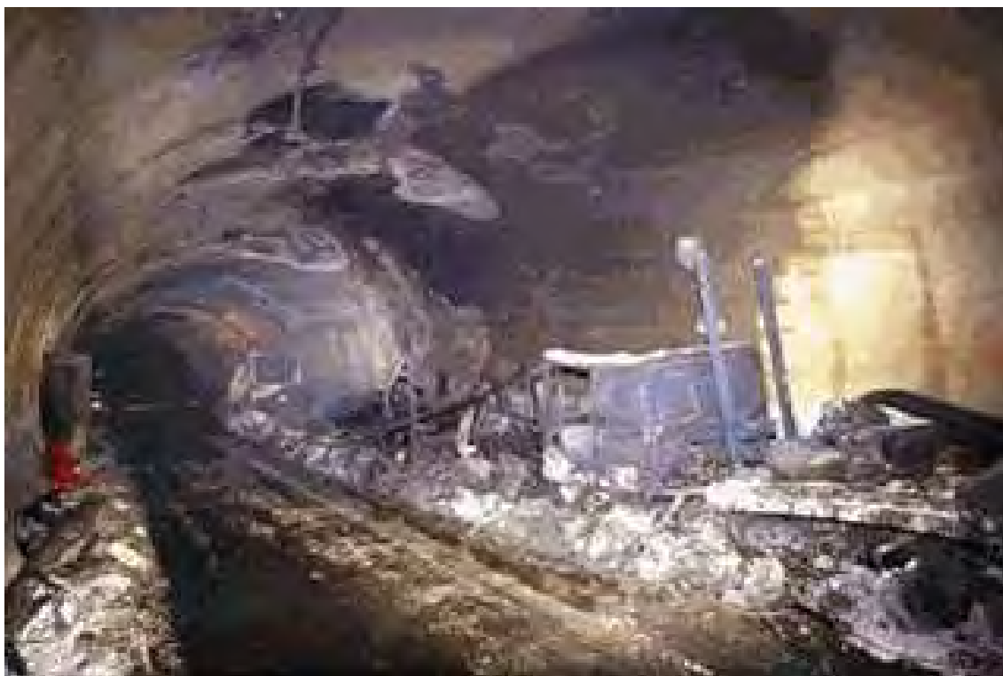
FIGURE 3.1 – Véhicules calcinés après l'incendie du tunnel du Mont-Blanc
