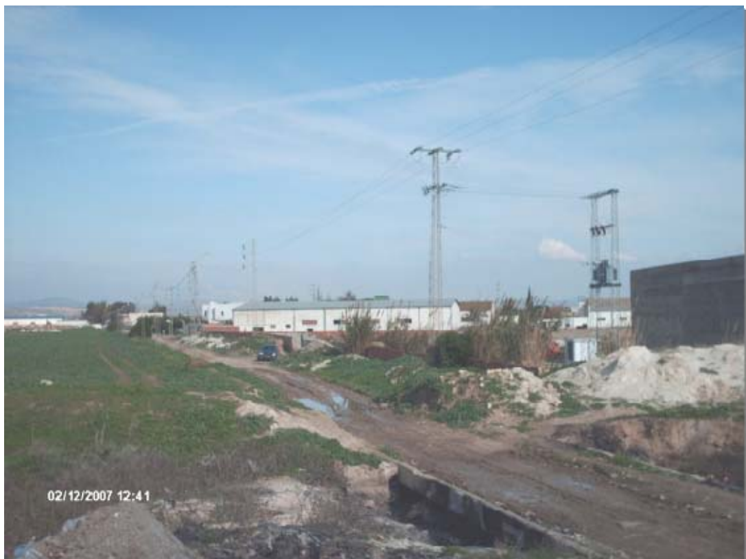
Photo n°29 : Les différentes usines dominant la partie Ouest de la zone industrielle d'Utique.
