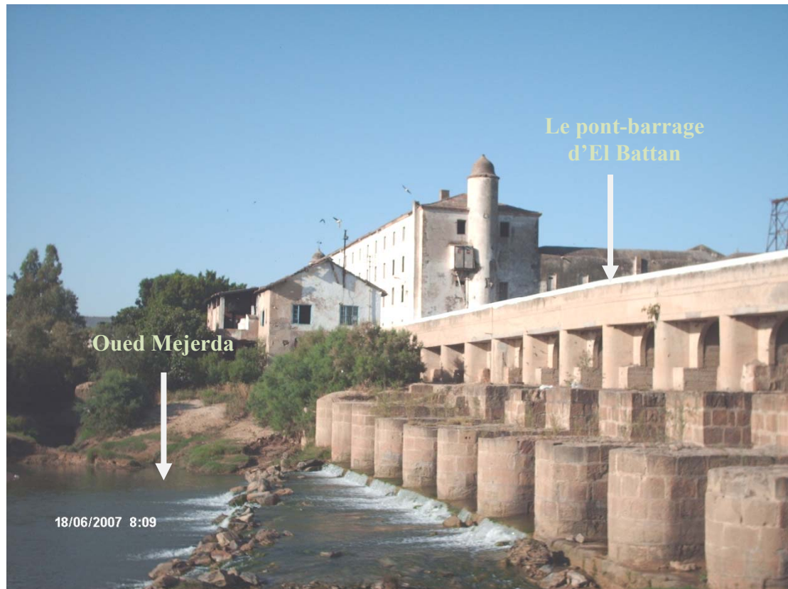
Photo n°2 : Le pont-barrage d'El Battan construit au début du XVII ème siècle n'assure aujourd'hui que sa première fonction.
