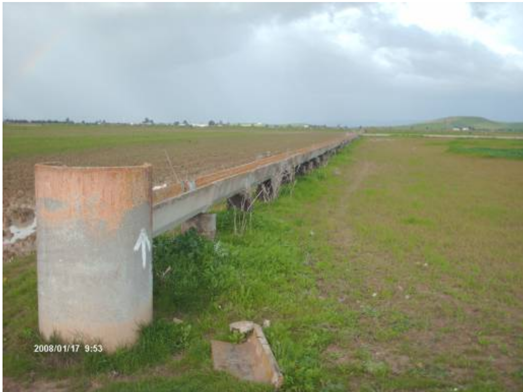
Photo n°15 : Exemple d'un canal quaternaire en ciment à Cherfech 1.
