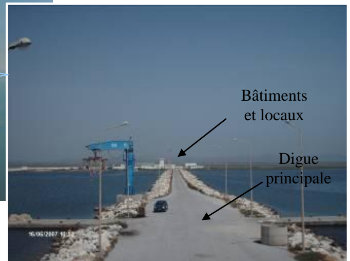
Photo n°28 : Digue principale d'accès au port de Kalaât Landalous.
