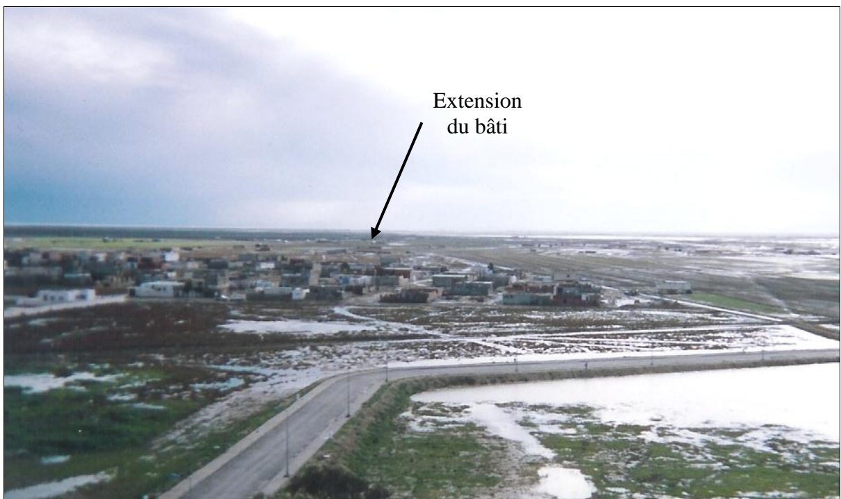
Photo n°30 : Extension du bâti dans les secteurs inondables à Kalaât Landalous. (HABANE A., 2004)
