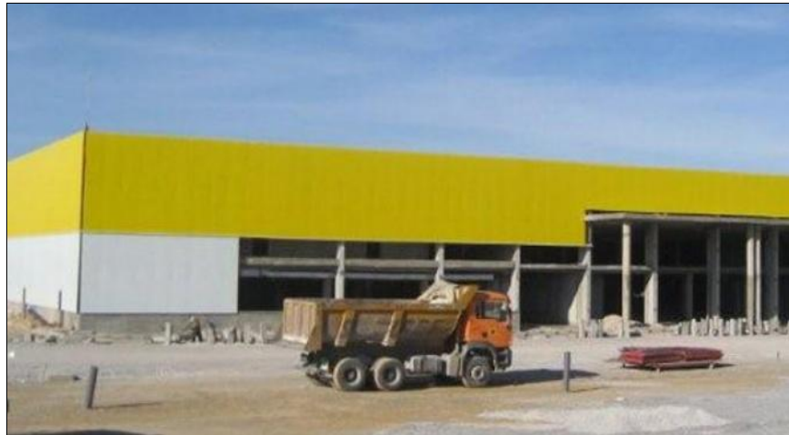
Photo n°36 : Bricorama-Tunisie : Chantier de finalisation.
