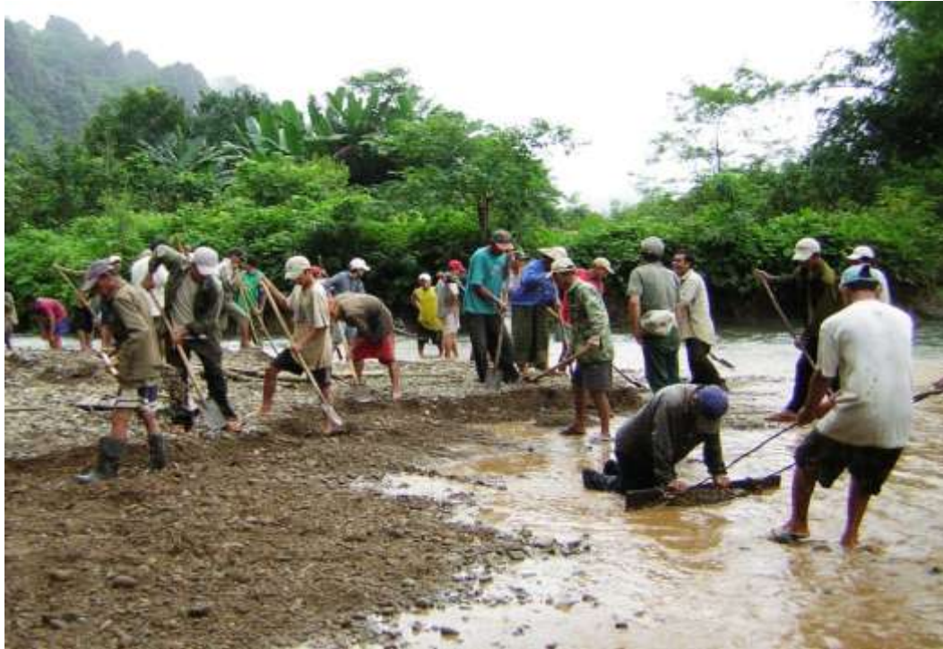
Photo 3 : Travaux collectifs à Phatang (entretien du barrage sur la Nam Pamome) (2006)
