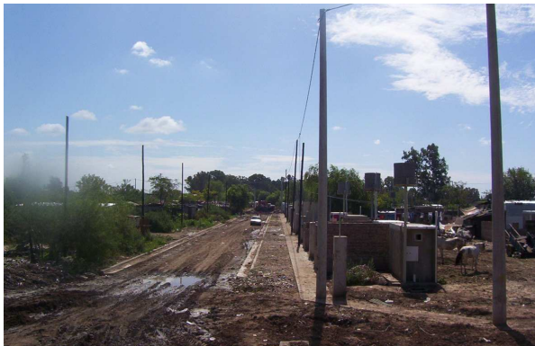
Photographie n°25 : Travaux de régularisation du quartier La Lagunita ©Rosario Habitat, 2003
