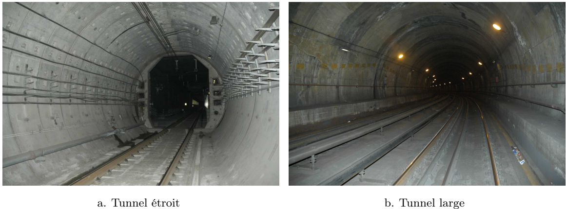
Figure 1.2 – Exemples de tunnels de section circulaire
