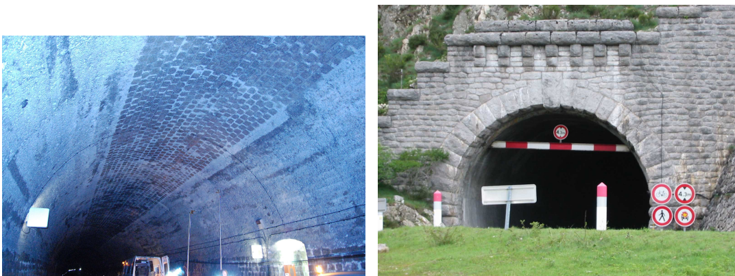
a. Tunnel vu de l'intérieur
