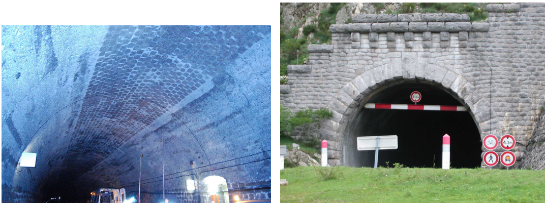
a. Tunnel vu de l'intérieur
