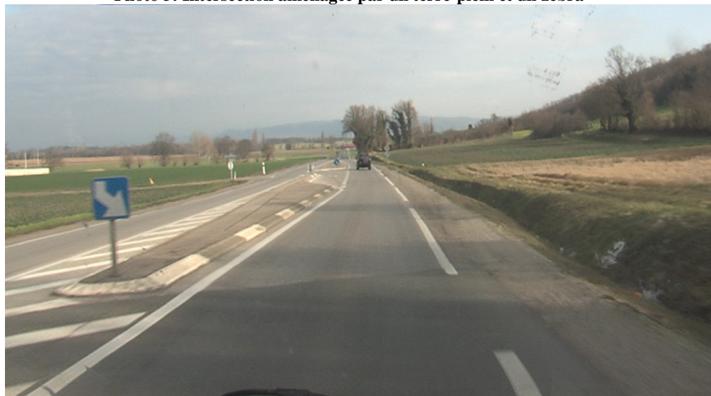
Photo 5: Intersection aménagée par un terre-plein et un zébra
