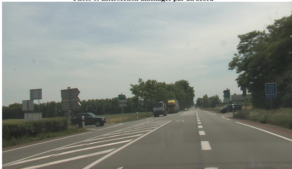
Photo 6: Intersection aménagée par un zébra
