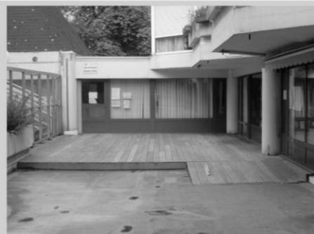
Le plan incliné présente une pente de 9% de dénivellation. Sur une longueur de moins de 2 mètres, la dénivellation tolérée doit être comprise entre 5 et 8%.
