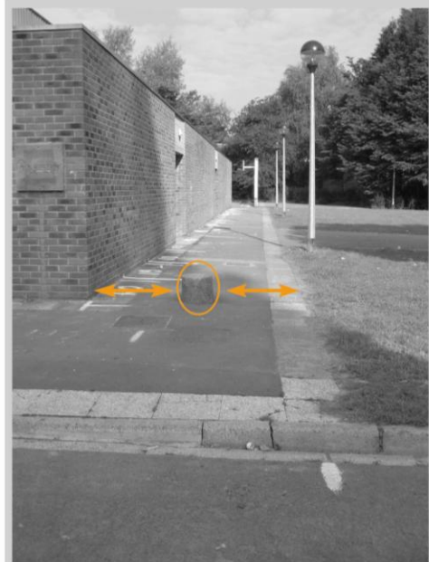
Aménagement de la voirie Villeneuve d'Ascq, 2008
