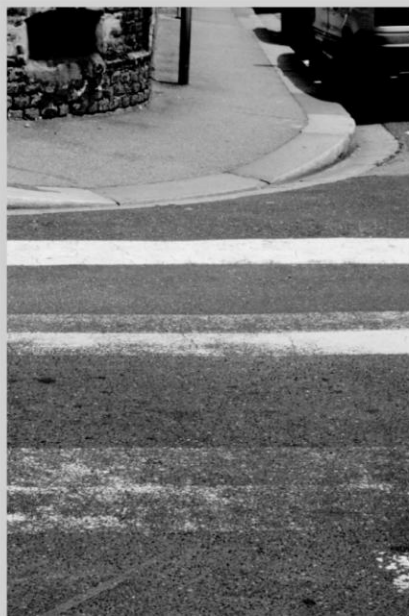
Un trottoir aménagé en "bateau" Le Havre, 2009
