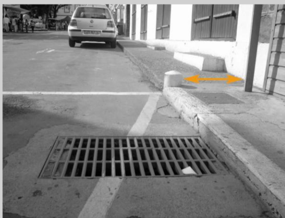
Aménagement de la voirie La Réunion, Saint-Pierre, 2009
