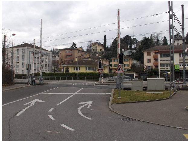
FIGURE 4.4 – Le passage à niveau "Pontet".
