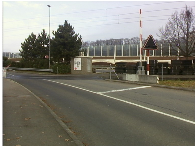
FIGURE 4.5 – Le passage à niveau "Chamberonne".
