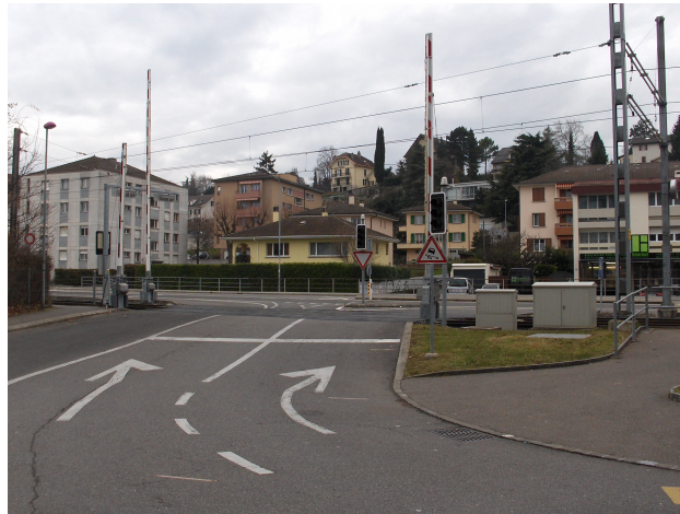
FIGURE 4.4 – Le passage à niveau "Pontet".
