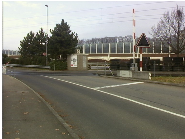
FIGURE 4.5 – Le passage à niveau "Chamberonne".
