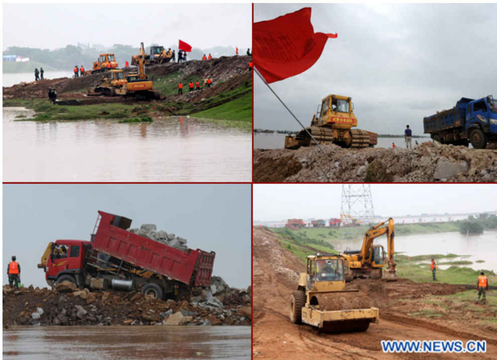
FIGURE 1.2: Inondation en Chine (juin 2010) : travaux de réparation de digues 3 .
