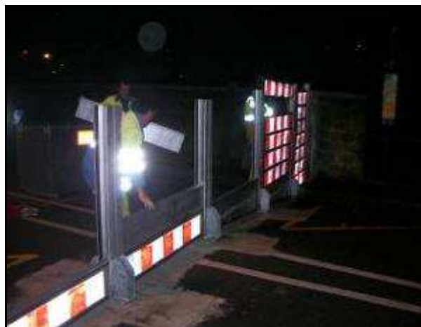
Photographie 20 : Pose des batardeaux avec signalisation intégrée lors de l'exercice de simulation du 13/11/2008 (Crédit photographie : Sébastien Baron, IAV)
