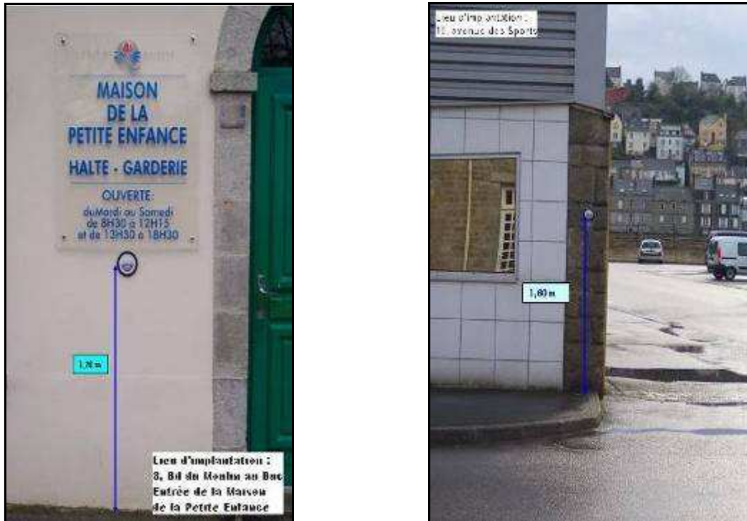
Photographie 5 : Repères de crues (crédit photographique : Mairie de Quimper)
