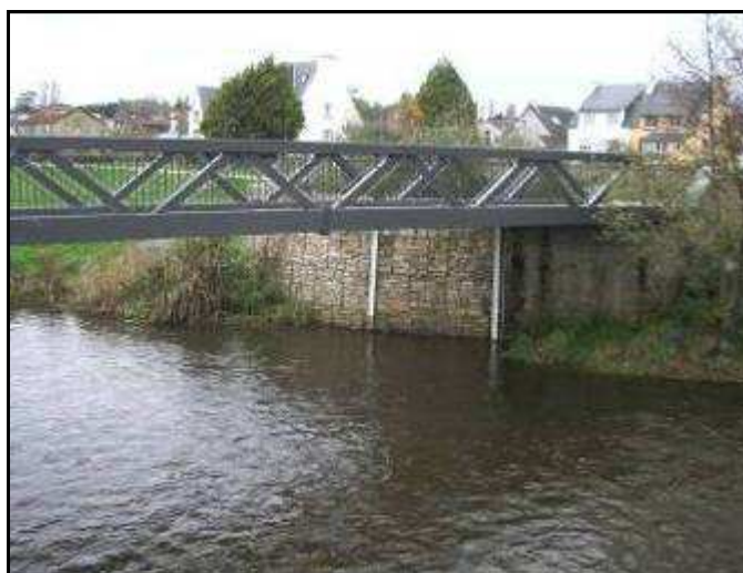
Photographie 18 : Passerelle remplaçant une passerelle avec pile faisant obstacle hydraulique (Crédit photographie : Sébastien Baron, IAV)
