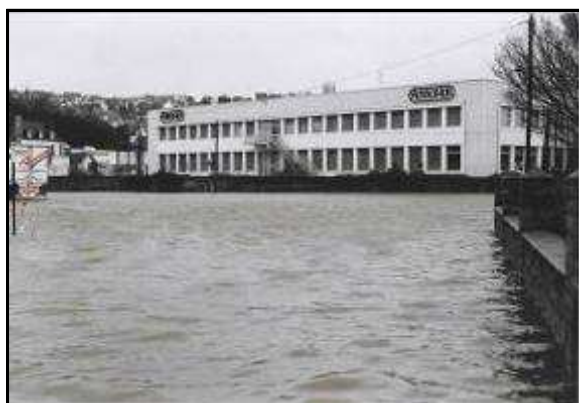
Photographie 15 : La Société Armor-Lux lors des inondations de 01/01/1995 (Crédit photographique : Patrick le Grand & DDE29)
