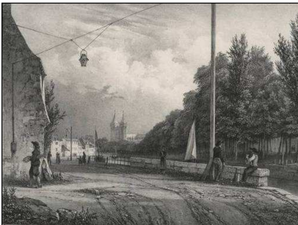
Figure 38 : Vue de Quimper à partir du chemin de Halage © Archives communales de Quimper
