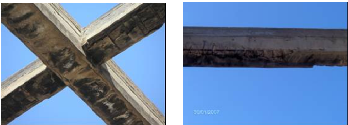
Figure III-32 Poutres endommagées
