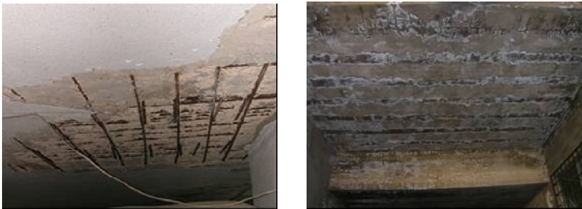
Figure III-31 Dalle endommagée
